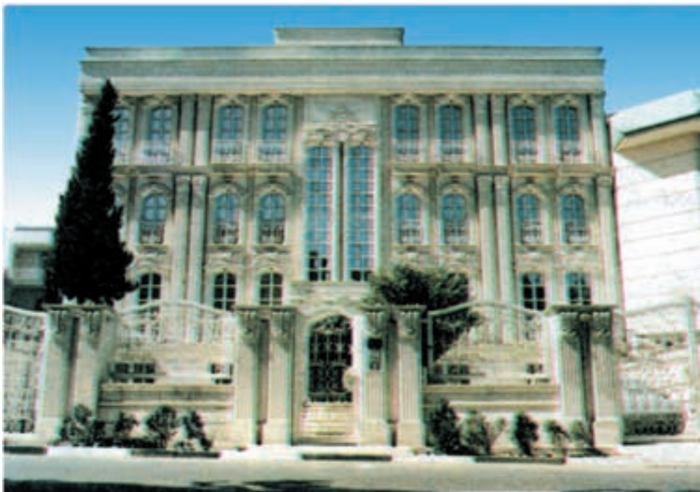
شکل ۲۱-۵- اجرای سیمان‌بری باروک
