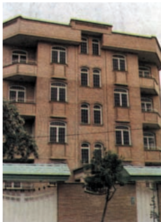
شکل ۶-۱- اجرای قوس در نمای آجری
