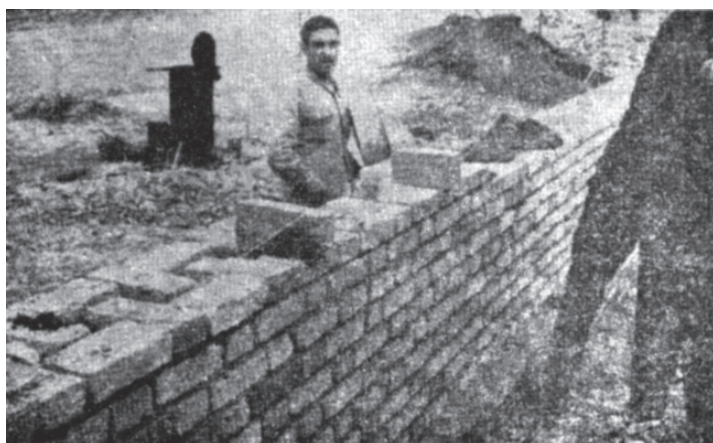
شکل ۵۱-۱- «نحوه‌ی بستن ریسمان با استفاده از وابند ریسمان»
