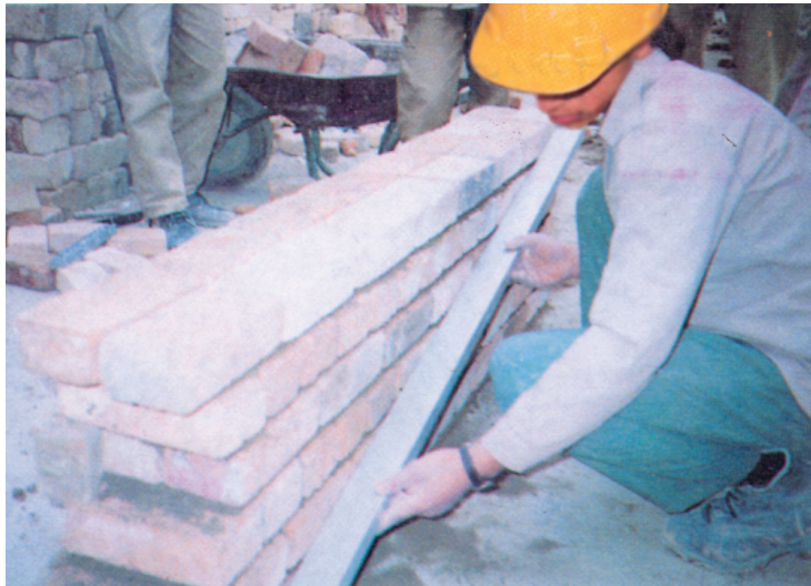
— مرحله‌ی اول طریقه‌ی ضربدری کنترل‌نما با شمشه (کنترل پیچیدگی نما)
