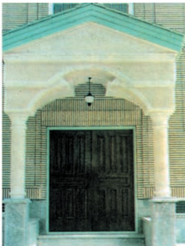
شکل ۲۰-۵- ستون‌سازی - سرستون‌سازی - قوس‌سازی سه کمانه - ابزارزنی - سیمان‌بری
