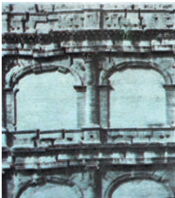
شکل ۳۵-۱- واکنش قوس نیم دایره از ناحیه‌ی تیزه و دو شانه
