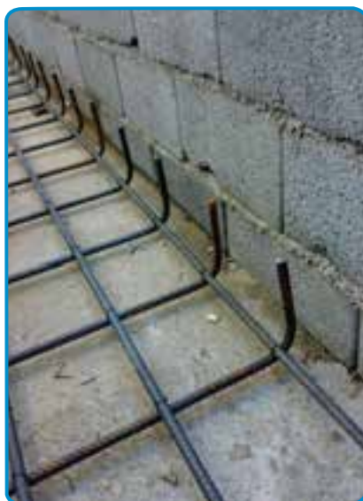
شکل ۱۰-۷- رعایت پوشش بتن در کف و بدنه
