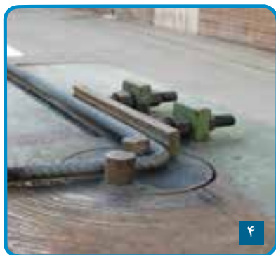
شکل ۳-۶۴ - خم کردن میلگرد
