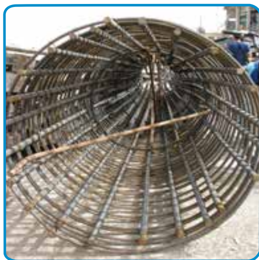
شکل ۲۰-۷- میلگرد گذاری مارپیچ در ستون
