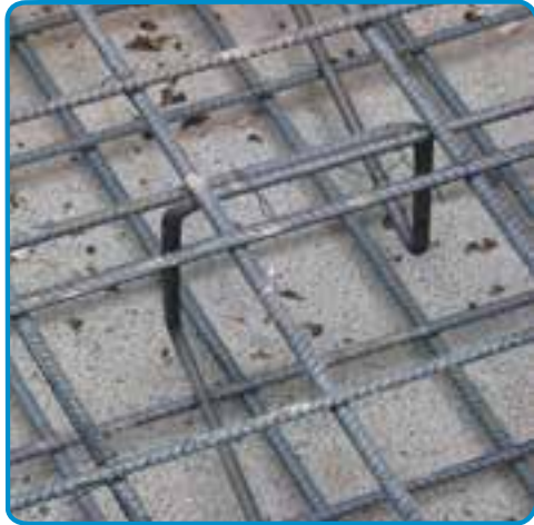
شکل ۳-۵۳- استفاده از خرک در میلگرد گذاری پی
