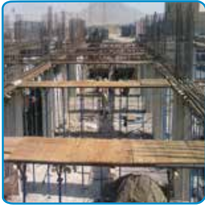
شکل ۷-۲۱- قالب بندی تیرها
