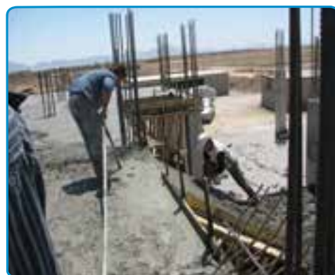
شکل ۴۲-۷- بتن ریزی دال پله
