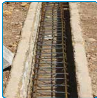
شکل ۵-۷- اجرای میلگرد شناژها
