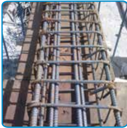
شکل ۷-۲۵- بستن خاموت ها با مفتول
