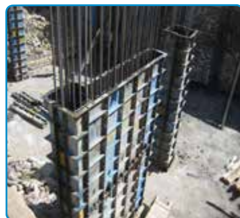
شکل ۳-۳۵- قالب فلزی برای اجرای دیوار بتنی
