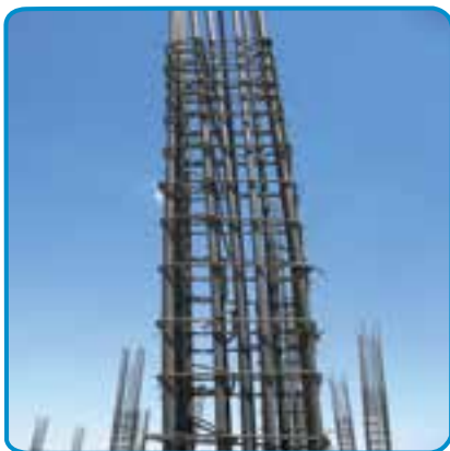
شکل ۱۹-۷- کار گذاشتن میلگردهای انتظار ستون، در فونداسیون
