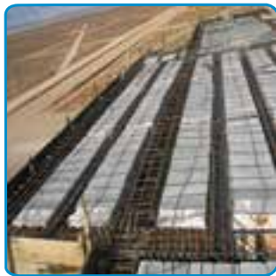
شکل ۳۳-۷-اجرای کنسول ها
