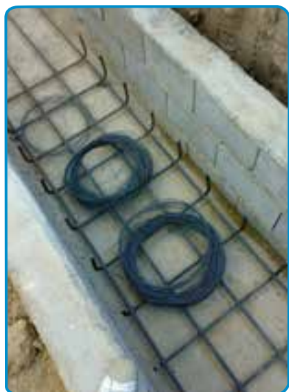
شکل ۹-۷- بهم بستن میلگردها
