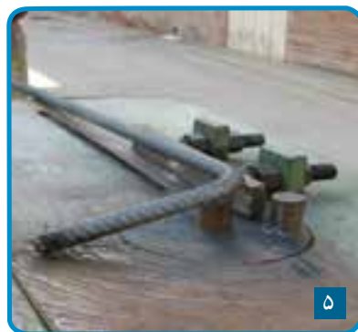
شکل ۳-۶۴ - خم کردن میلگرد
