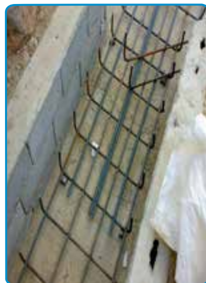
شکل ۱۱-۷- قرار دادن میلگردهای تقویتی
