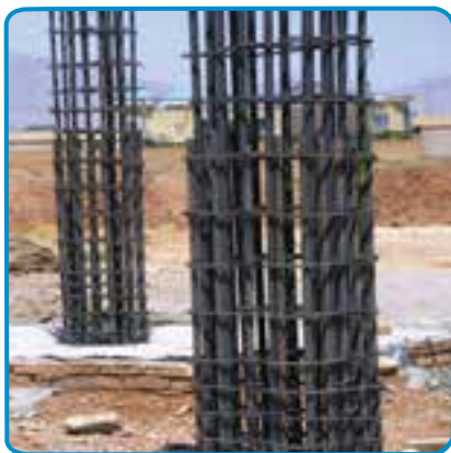
شکل ۱۶-۷- بتن ریزی ستون
