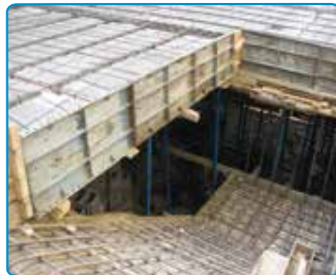
شکل ۴۰-۷- اجرای میلگردهای دال پله
