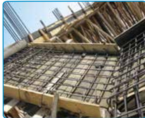
شکل ۳۸-۷- اجرای میلگردهای دال پله
