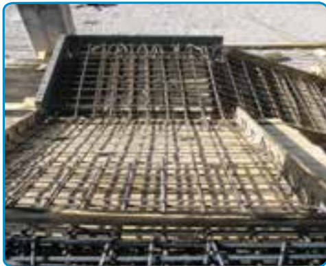
شکل ۳۷-۷- اجرای میلگردهای دال پله
