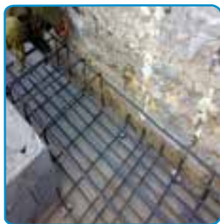
شکل ۱۲-۷- میلگردگذاری شبکه بالای
