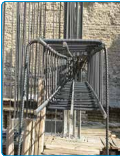
شکل ۳-۴۵- میلگرد طولی در تیر
