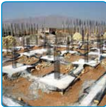
شکل ۱۷-۷- اجرای خاموت و سنجاقک
