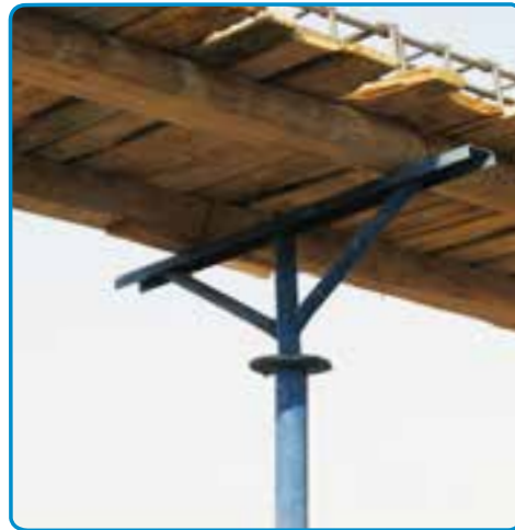
شکل ۳-۲۱- استفاده از شمع‌های فلزی جهت نگهداری قالب‌ها
