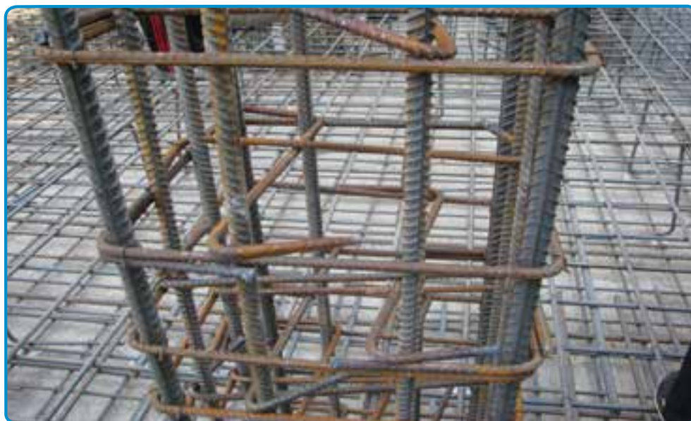
شکل ۵۰-۳- کاربرد سنجاقک در میلگرد گذاری ستون
