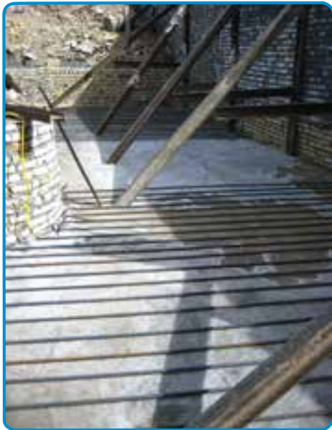
شکل ۳-۴۶- میلگرد طولی کف پی
