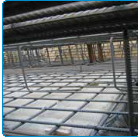
شکل ۳-۵۳- استفاده از خرک در میلگرد گذاری پی
