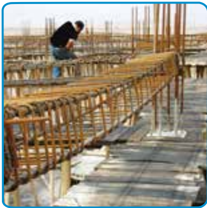
شکل ۷-۲۴- تنظیم فاصله بین خاموت ها
