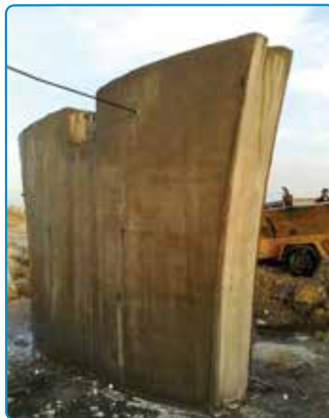
شکل ۳-۴۲- قالب برداری
