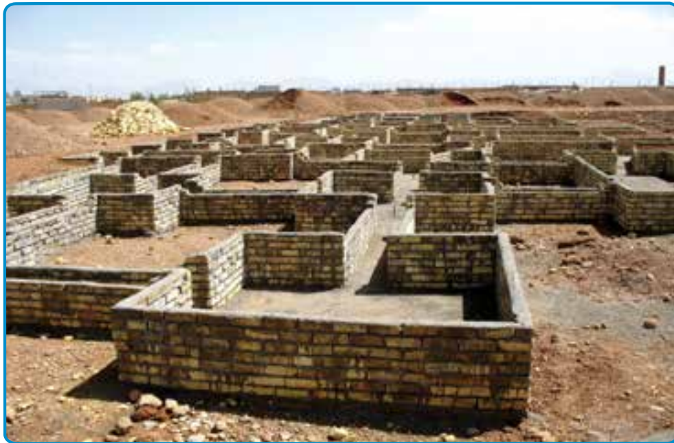
شکل ۱۵-۳- استفاده از قالب آجری برای اجرای پی
