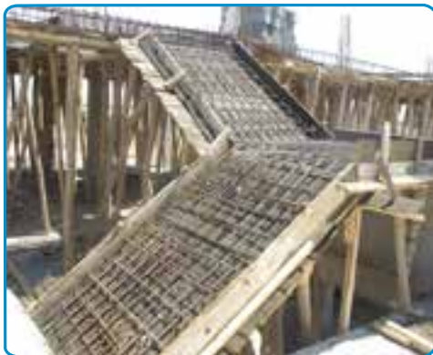
شکل ۳۹-۷- اجرای میلگردهای دال پله
