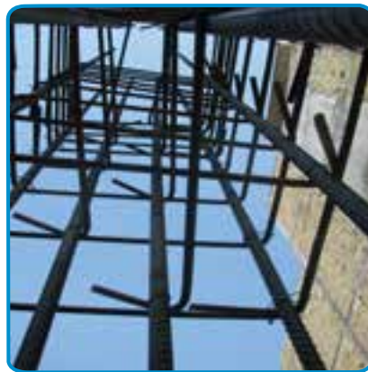
شکل ۱۹-۷- کار گذاشتن میلگردهای انتظار ستون، در فونداسیون
