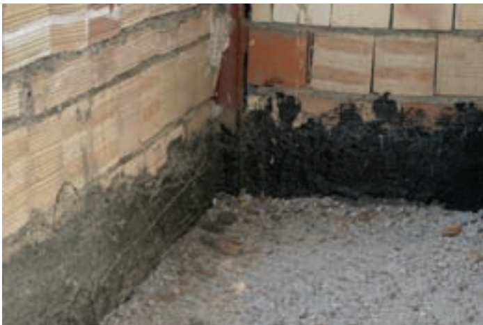
تصویر ۱۶ - عایق کاری کف سرویس بهداشتی
