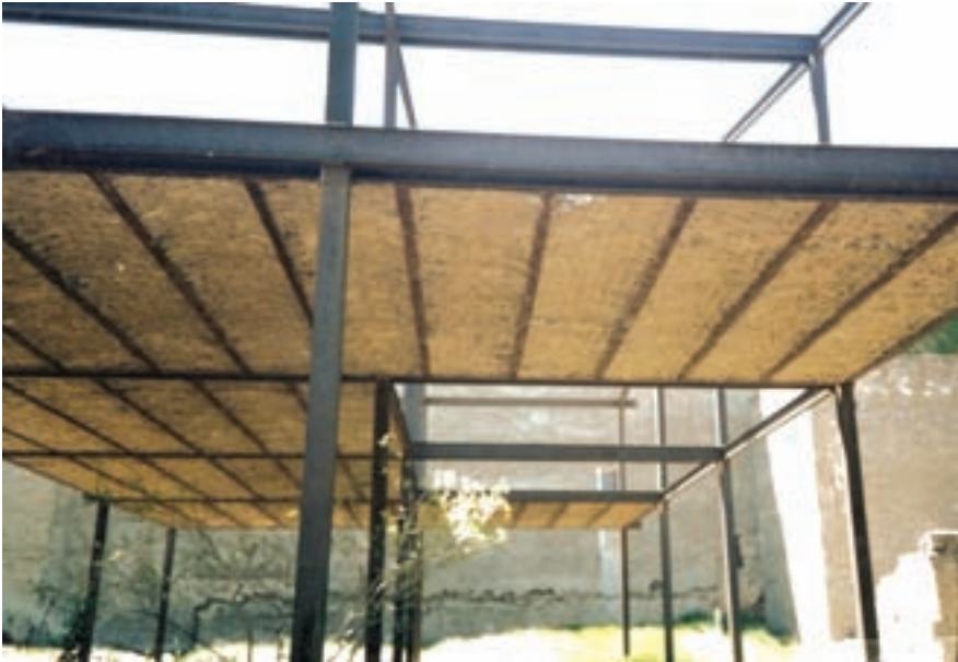
تصویر ۱۰ - تیرریزی سقف طاق ضربی
