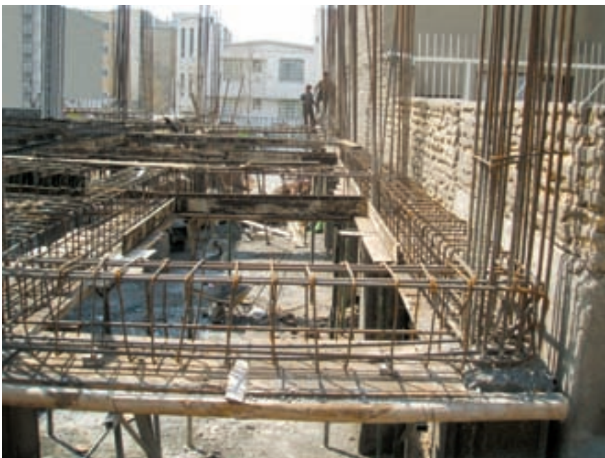
تصویر ۱۲ - نحوه‌ی قرارگیری آرماتورهای کلاف‌های بتنی
