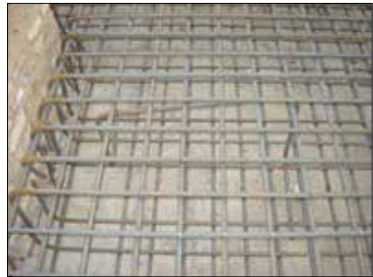
شکل ۱۴۷-۲ پی نواری و آرماتورگذاری آن
