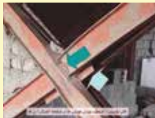
ضعیف بودن جوش و عدم اتصال مناسب
