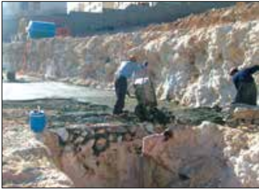
شکل ۸۷-۱ گودبرداری دستی (با بیل و کلنگ)
