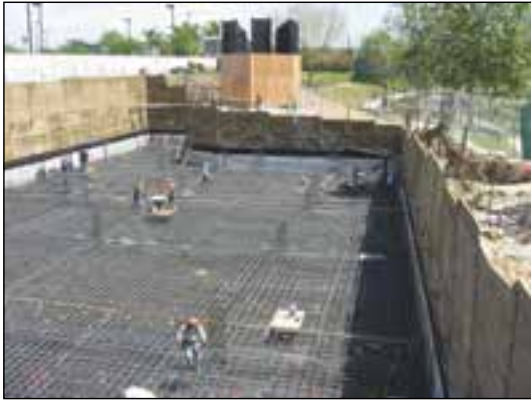
شکل ۱-۶۲ پی بتن مسلح یکپارچه (رادیه ژنرال)
