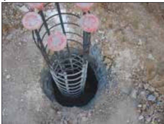
شکل ۱-۷۳ پی چاهی در حال اجرا
