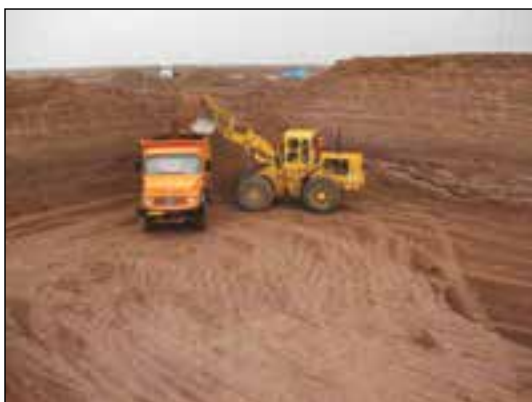
شکل ۸۵-۱ گودبرداری با لودر در زمین نامحدود
