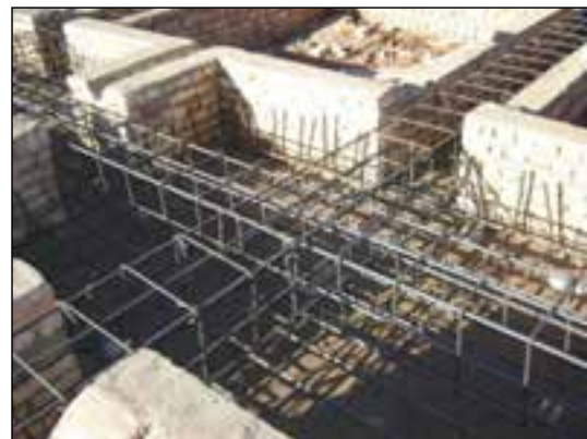
شکل ۷۱-۲ عبور میلگردهای شناژ در پی
