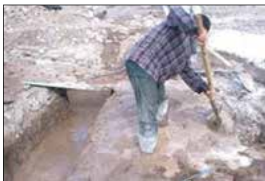
شکل ۱-۳۱ اجرای شفته آهک در فونداسیون
