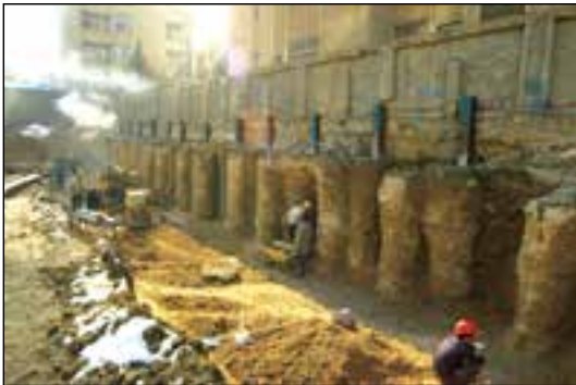
شکل ۸۸-۱ مهاربندی با پشت بند خاکی ستونی
