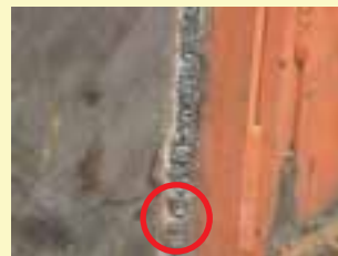
عدم جوش پیوسته - لوچه
