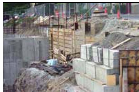
شکل ۹۱-۱ مهاربندی با دیوار مانع چوبی
