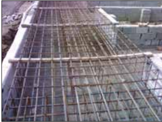
شکل ۱۴۶-۲ پی نواری و آرماتورگذاری آن
