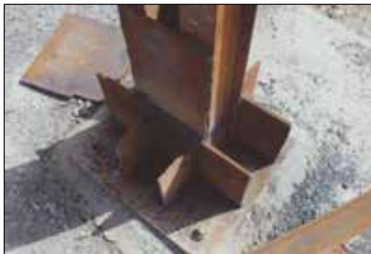
شکل ۱۶۸-۲ اتصال گیردار
