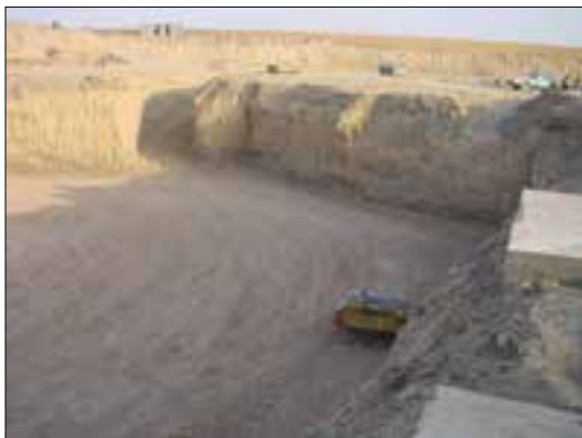
شکل ۸۴-۱ زمین گودبرداری شده
