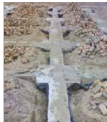
شکل ۷۳-۲ پی و شناژ بعد از بتن ریزی
