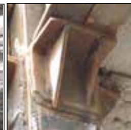
اتصال تیر به ستون به صورت لچکی
