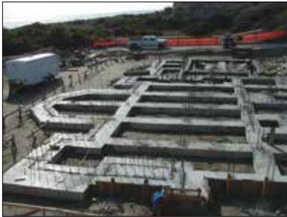
شکل ۱-۵۶ پی بتن مسلح نواری شبکه ای زیرستون
