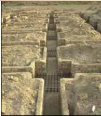
شکل ۴۸-۱ آرماتورگذاری پی تکی کلاف بندی شده
