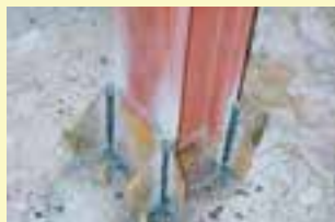
اتصال مناسب و جوش صحیح
