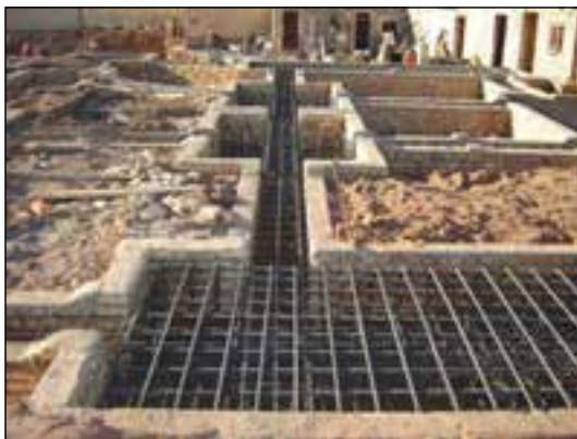
شکل ۷۰-۲ میلگردگذاری در پی کلاف بندی
