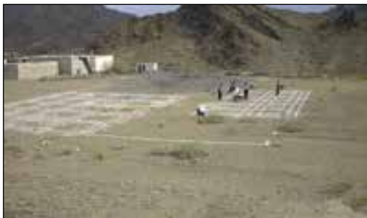
شکل ۸۳-۱ پیاده کردن نقشه روی زمین
