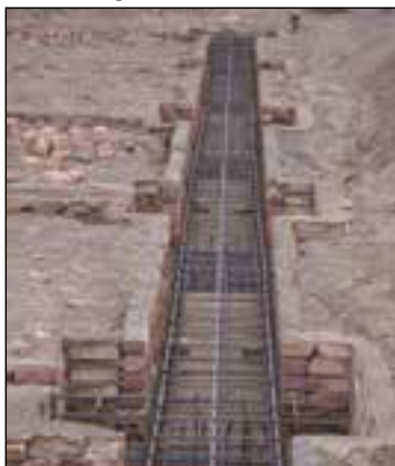
شکل ۷۲-۲ پی و شناژ قبل از بتن ریزی
