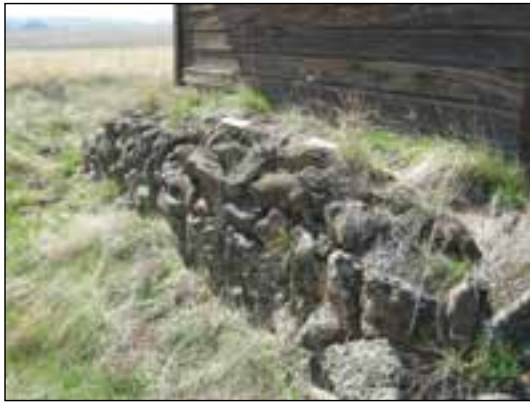
شکل ۱-۳۲ پی سنگی با سنگ لاشه
