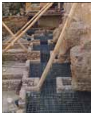
شکل ۹۰-۱ مهاربندی با شمع چوبی
