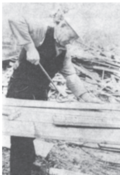
شکل ۱-۳۰ - میخ‌کشی از تخته توسط میخ‌کش اهرمی
