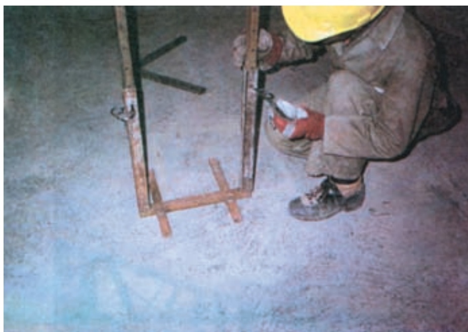
شکل ۹۵-۲- خرک قابل تنظیم برای ارتفاع های متفاوت
