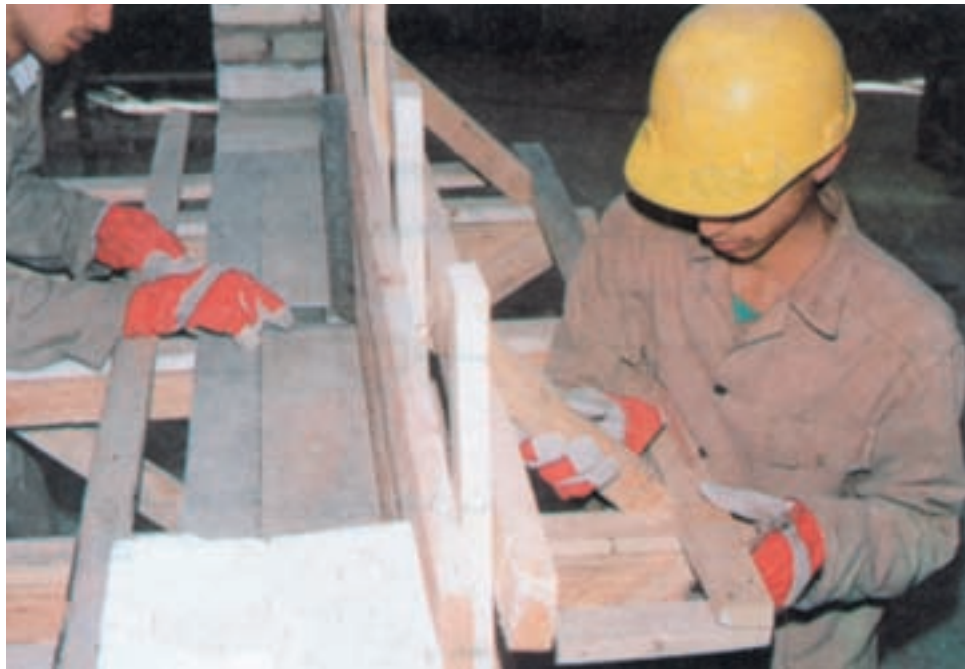
شکل ۱۱-۳- نصب گوننه، گونیاکردن و نصب دستک‌ها
