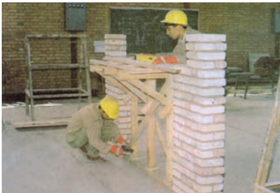
شکل ۶-۳- صفحه‌ی کف قالب نصب شده بر روی شمع‌ها
