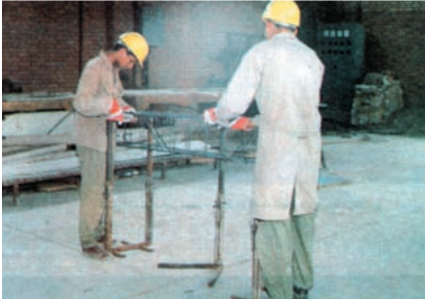
شکل ۱۲-۳- طریقه‌ی مونتاژ آرماتورهای یک پوتر کوچک
