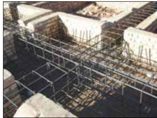
شکل ۳-۱۳۵ عبور میلگردهای شناژ در پی
