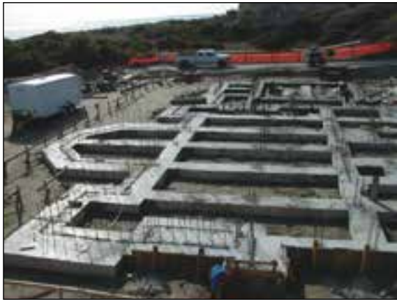
شکل ۳-۶۲ پی بتن مسلح نواری شبکه ای زیرستون
