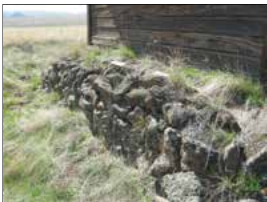
شکل ۳-۴۰ پی سنگی با سنگ لاشه
