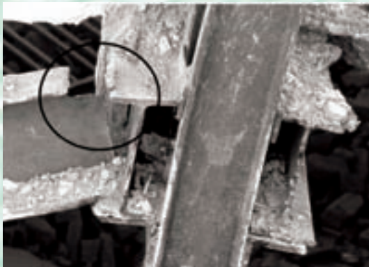
شکست اتصال تیرچه به تیر اصلی در زلزله بم
