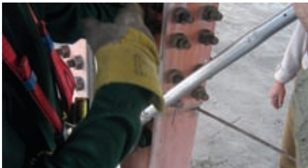
شکل ۷-۳- استفاده از پیچ‌های پرمقاومت در اتصالات
