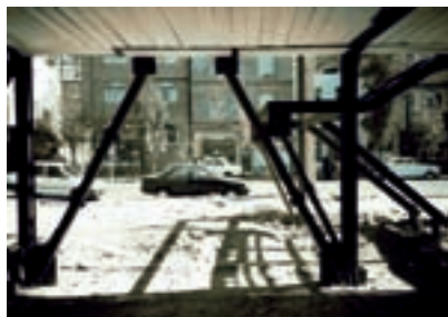
ب- مهاربند ذوزنقه واگرا در اسکلت فولادی
