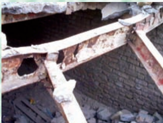
اتصال نادرست مفصلی تیر و ستون موجب تخریب سازه در زلزله بم شده است.
