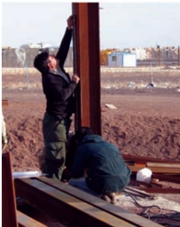
ب - تنظیم پای ستون نسبت به خط محور و شاقول کردن آن
