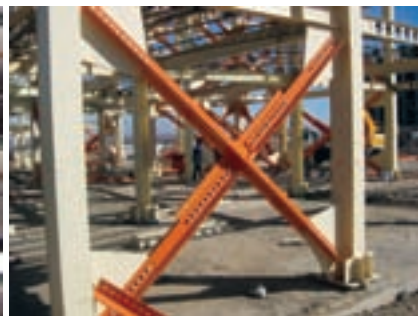
الف- مهاربندهای همگرا در اسکلت فولادی
