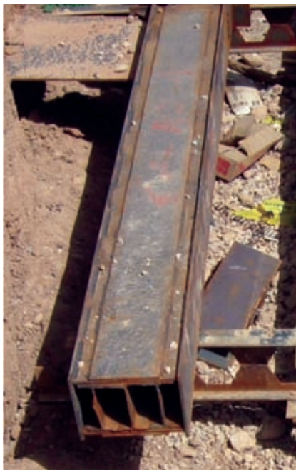
شکل ۴-۱۸- مقطع مرکب سه‌تایی با ورق تقویتی
