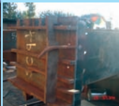
استفاده از مهار پشت‌بند جهت جلوگیری از تاب برداشتن ورق کف ستون در کارخانه
