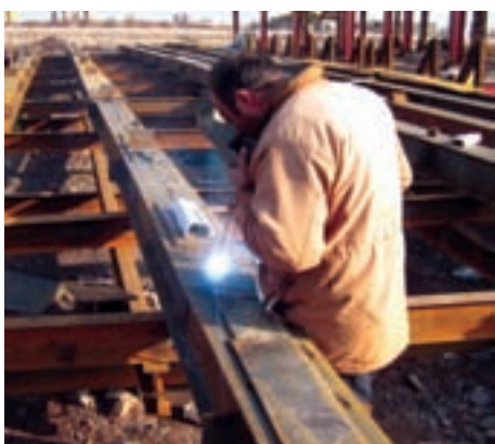
شکل ۴-۱۵- جوشکاری ستون جفت (وی شاسی کار)
