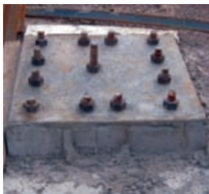
(ب) پس از بتن‌ریزی
