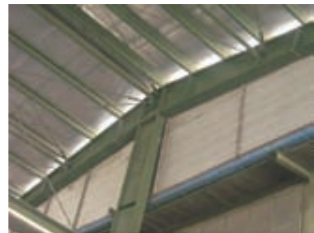
شکل ۱۰-۳۱- اجرای مهاربند افقی در قاب شیبدار
