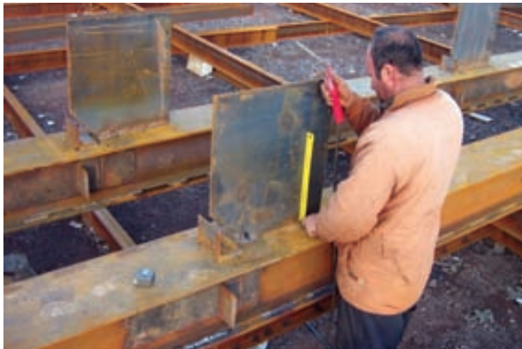
شکل ۴-۲۲- نصب ملامقات ستون روی شاسی‌های مونتاژ
