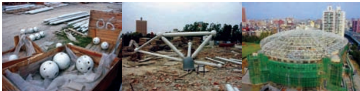
شکل ۱۰-۱۵- نمایی از یک فرپای فضایی
