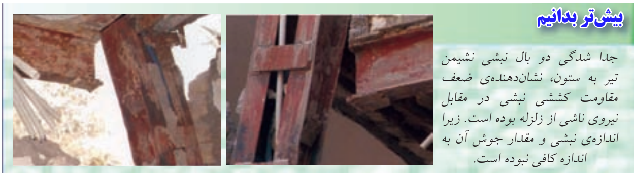
شکل ۸-۱۹- نمونه‌هایی از اتصال ستون به ورق پای ستون
