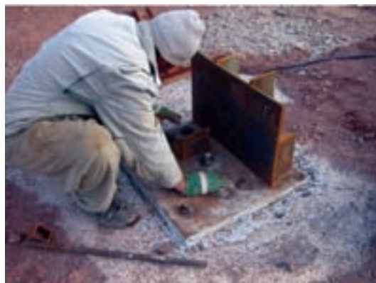
الف - آماده‌سازی و تمیزکاری صفحه ستون قبل از نصب ستون (تراز کردن صفحه ستون، هواگیری و گروت ریزی، فکاشی و تعیین خط آکس، جوشکاری نبشی‌های نصب و تمیزکاری صفحه ستون)
