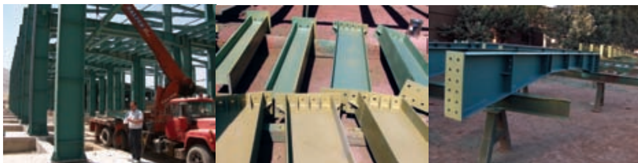
سافت و نصب اسکلت صنعتی
