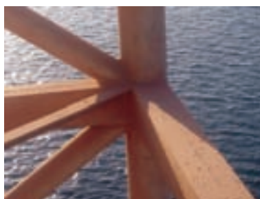
ستون با مقطع دایره در یک سازه صنعتی در جزیره خارگ
