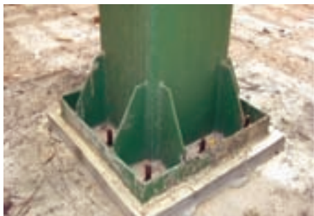
ت- پای ستون پس از سافت، نصب و گروت‌ریزی
