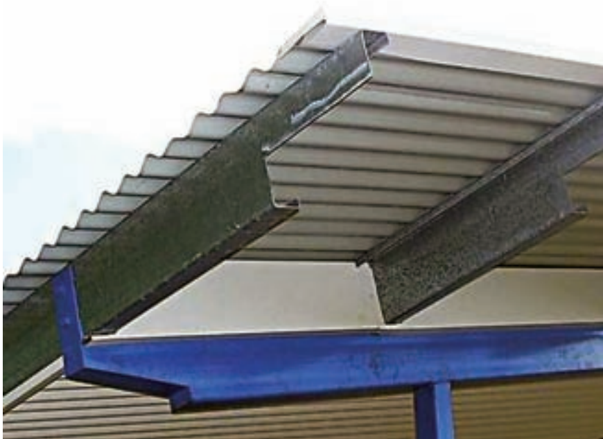
شکل ۵-۱۹- لایه جهت نصب پوشش در ساختمان صنعتی
