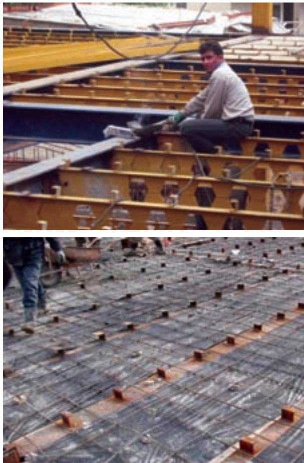
شکل ۵-۲۵- مراحل اجرای سقف کامپوزیت
