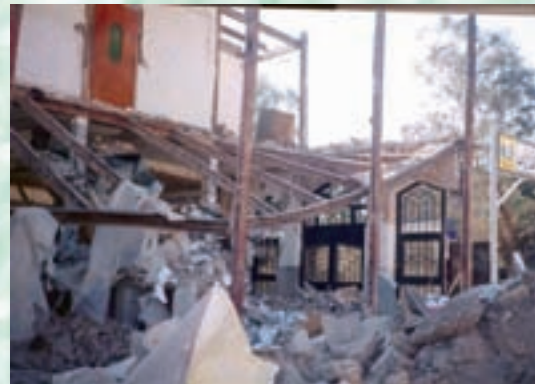
اجرای ناصحیح نبشی نشیمن در تکیه‌گاه تیرو ستون، منجر به تخریب کلی سقف شده است.
