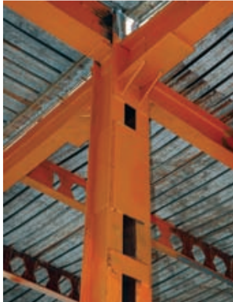
شکل ۴-۲۱- اتصال تیر به ستون دابل پا باز
