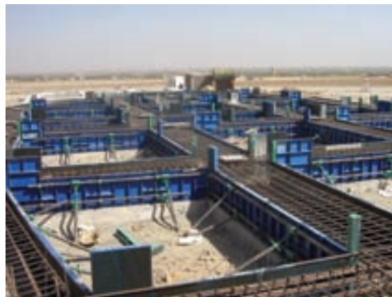
شکل ۳-۱۰- مراحل اجرای شالوده
