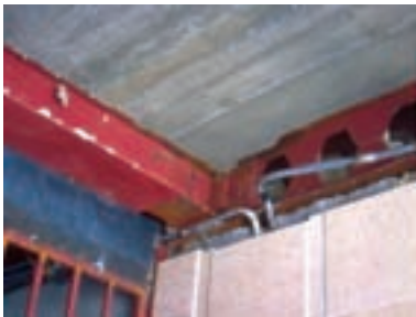
شکل ۵-۲۰- سافت تیرهای لانه زنبوری و نصب آن‌ها
