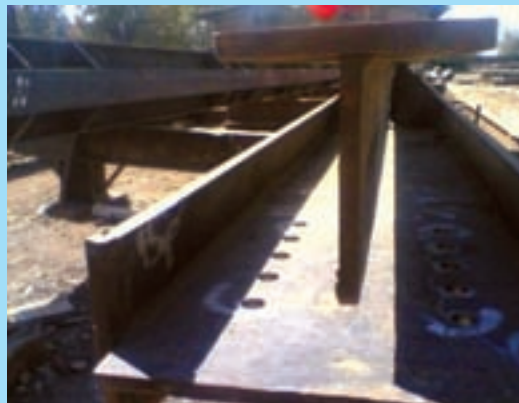
مونتاژ وجوه سوم و چهارم در روش مونتاژ تک مرحله‌ای ستون‌های صلیبی
