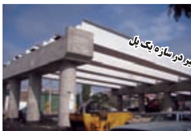
نمونه‌ای از تیر در سازه یک پل فولادی
