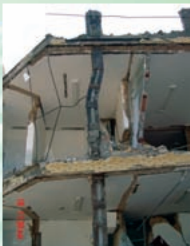
نمونه هایی از کمانش کلی ستون
