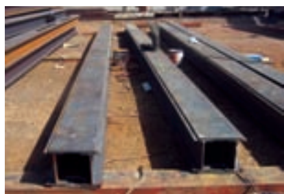
شکل ۴-۱۶- ستون دابل با ورق تقویتی یکسره
