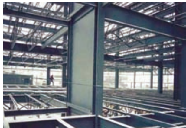
شکل ۹-۳- دیوار برشی بتنی در سازه فولادی
