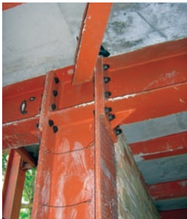
شکل ۷-۸- اتصال پیچی در سافتمان اسکلت فولادی
