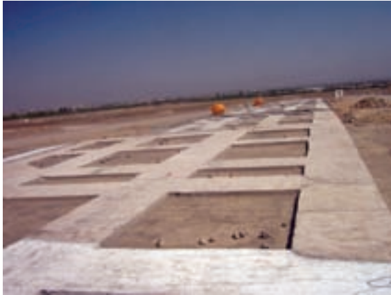
الف- اجرای بتن مگر
