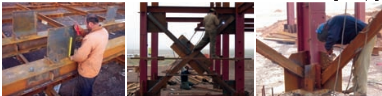
شکل ۸-۱۷- نمونه‌ی اجرای اتصالات مهاربندی
