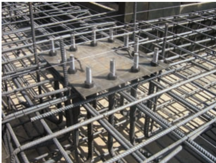
شکل ۳-۱۲- تنظیم پیچ‌های مهاری با شابلن و ریسمان
