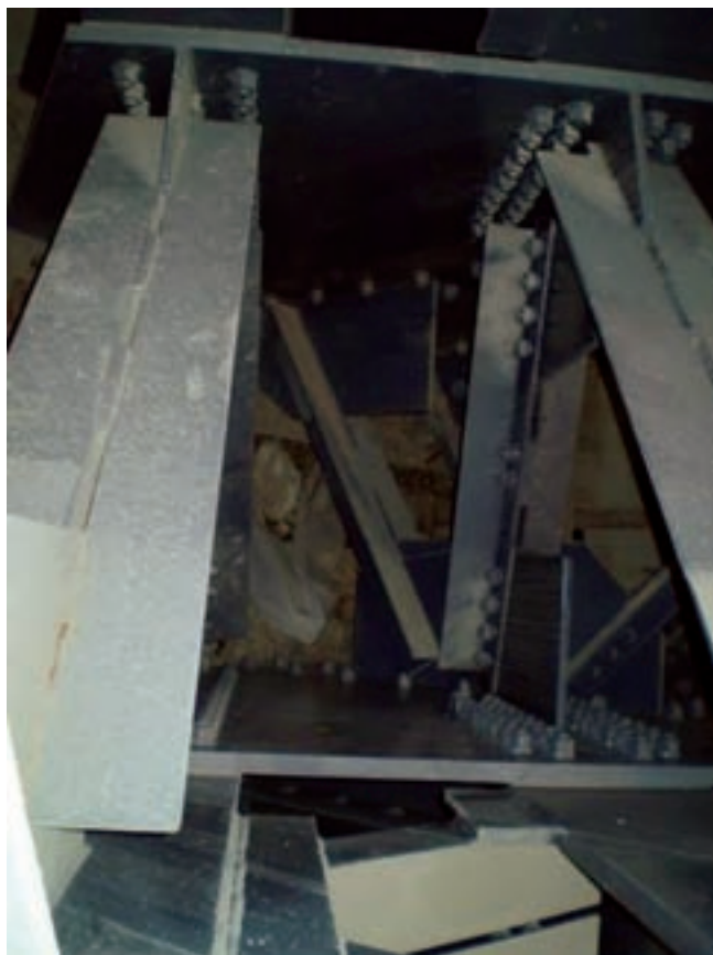
شکل ۱۰-۶ - اتصال پیچ و مهره‌ای اعضای خریاها
