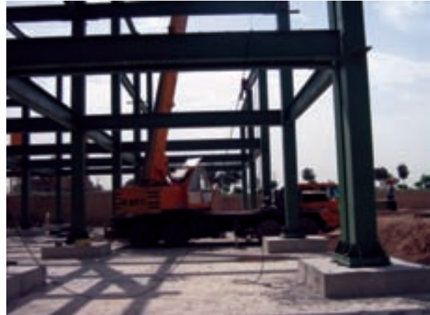
شکل ۹-۲- قاب فمثنی در سازه فولادی
