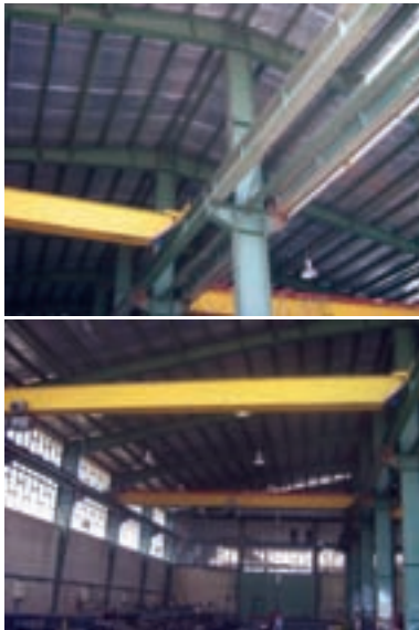
پ- کاربرد جرثقیل سقفی در ساختمان صنعتی
