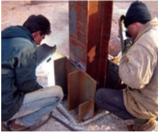
شکل ۴-۲۶- جوشکاری کامل پای ستون و مملقات آن
