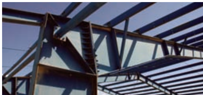
شکل ۱۰-۳۴- اجرای ماهیچه در محل اتصال تیر به ستون
