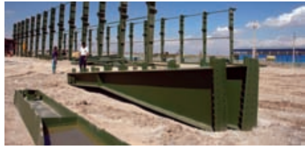
شکل ۵-۱۵- شاهتیرهای ساخته شده از تیر ورق
