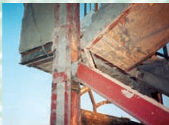
ضعف اتصال مفصلی تیر و ستون موجب تخریب سازه در زلزله شده است.
