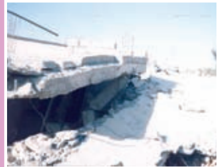
شکست ستون از محل درز اجرایی
