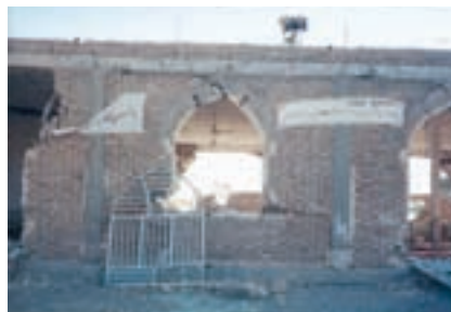
فاصله‌ی زیاد شن‌های قائم و فقدان پیوستگی دیوار به شن‌ها قائم موجب تخریب دیوار شده است.
