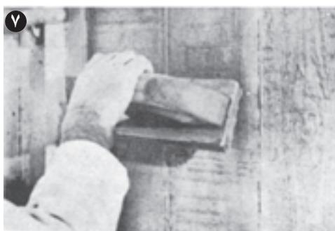
شکل ۶-۴۲- روش ترمیم دوغاب‌های اضافی که از محل درز بین دو قالب بیرون زده است.
