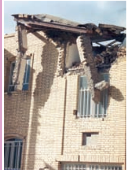
جدا شدن شنازهای قائم خربشته از سازه به دلیل ناکافی بودن طول وصله
