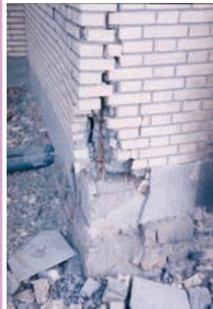
بتن‌ریزی نادرست شناژ قائم
