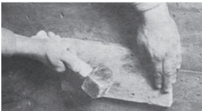
متراکم کردن با یک تخته و چکش
