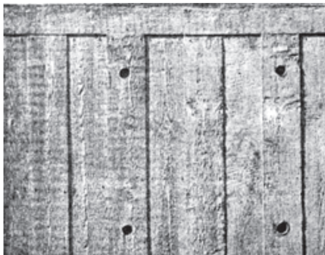
شکل ۶-۳۴- نمونه‌ای از محل‌های مهاری پر نشده
