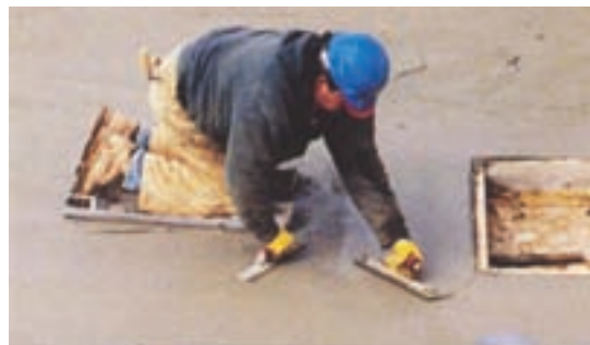
شکل ۶-۲۸- پرداخت نهایی با ابزار دستی
