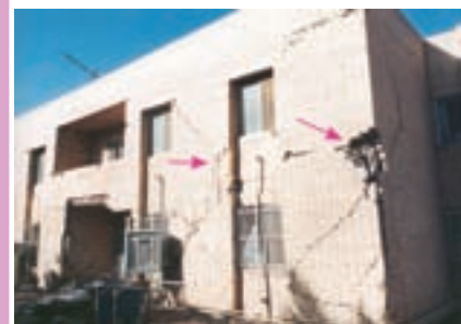
ایجاد ترک‌های قطری در اثر ضعیف بودن سناژ قائم
