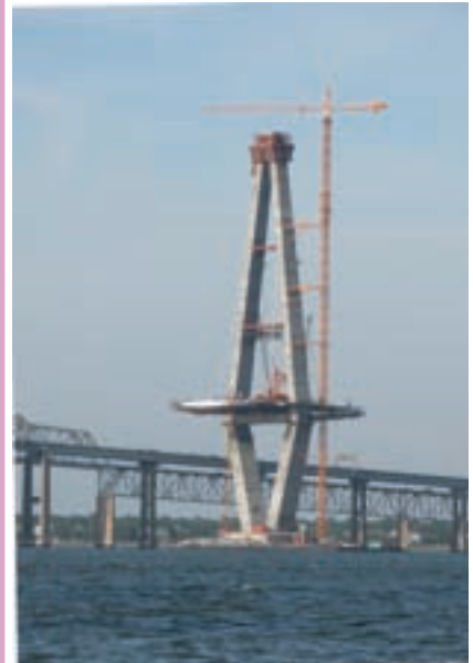
پایه‌ی بتنی یک پل کابلی
