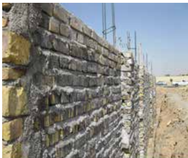
شکل ۱ - ۲۶: دیوار آجری با کلاف بندی قائم
