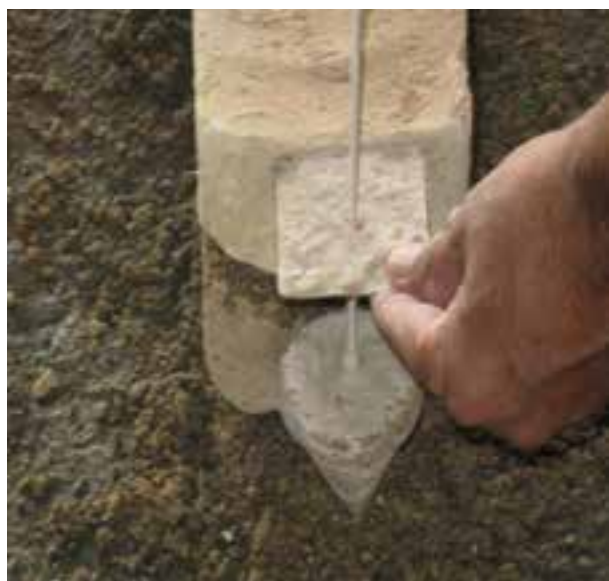
شکل ۱-۹۴: شاقول کردن نبش کار
