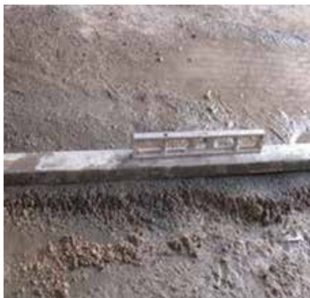
شکل ۱ - ۸۶: کنترل تراز سطح ملات
