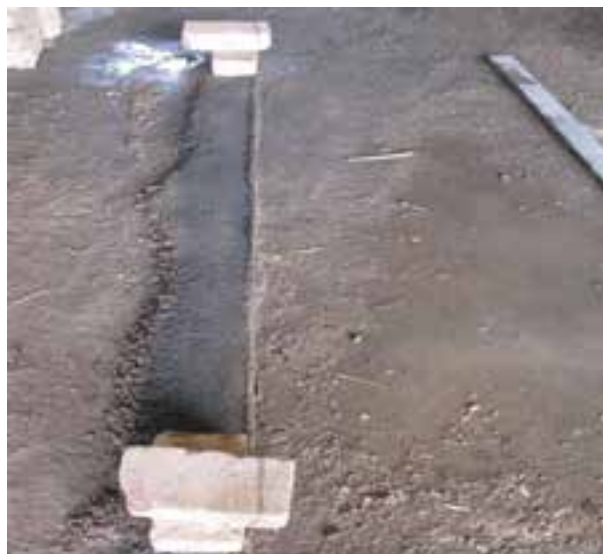
شکل ۱-۷۳: بادخور نمودن ریسمان کار
