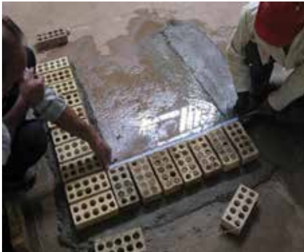
شکل ۱ - ۳۳ (الف): برداشتن طول دیوار
