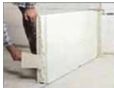
شکل ۱ - ۳۶: طریقه نصب بلوک های گچی
