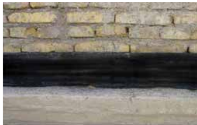
شکل ۱- ۳۰: دیوار روی کرسی چینی
