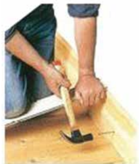
شکل ۳- ۲۹: نصب قرنیز چوبی با میخ
