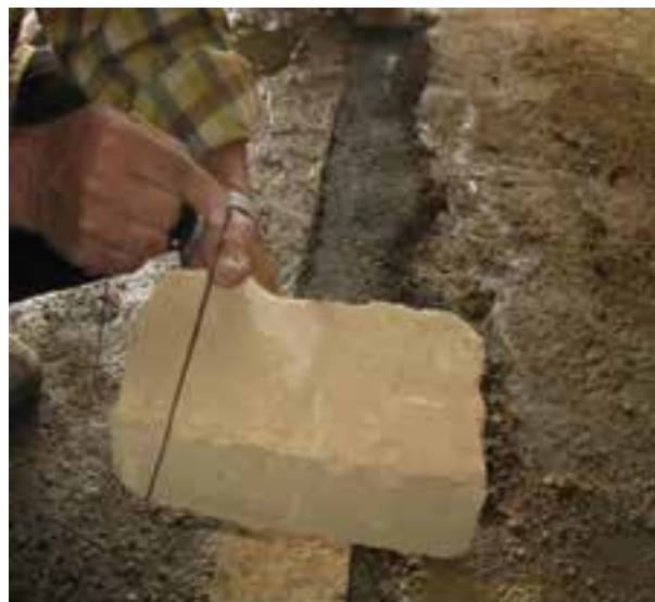
شکل ۱-۷۲: نحوه بستن ریسمان کار به آجر
