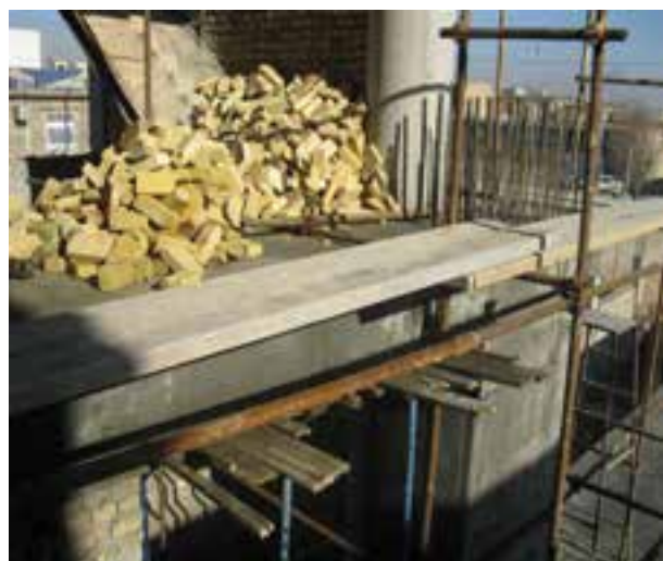
شکل ۱-۲: ضخامت مناسب برای تخته زیر پای
