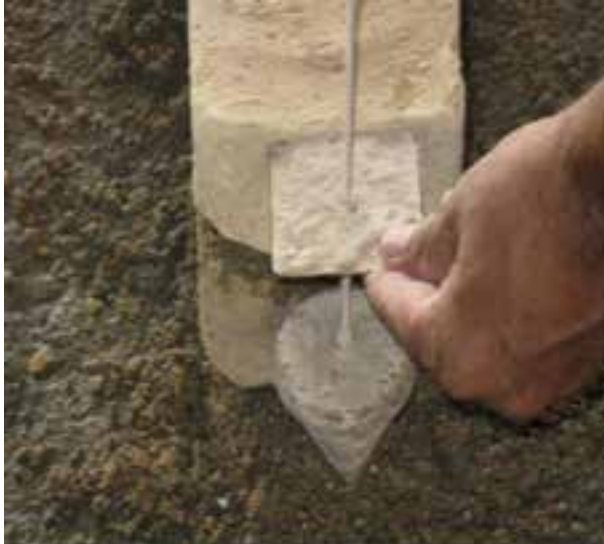
شکل ۱- ۷۷: شاقول کردن نبش کار
