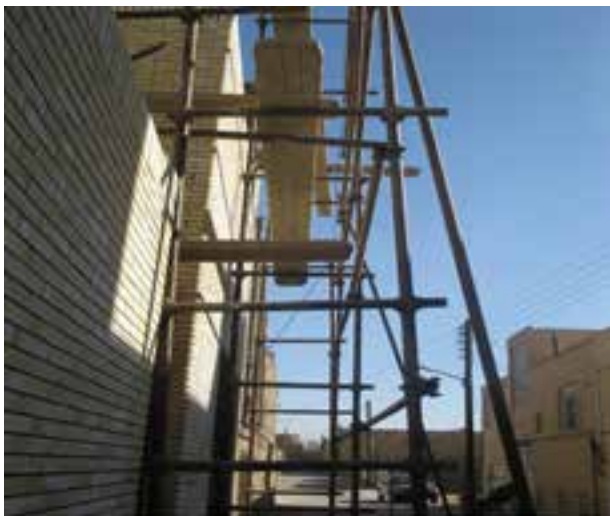
شکل ۱-۱: داربست فلزی برای چیدن دیوار
