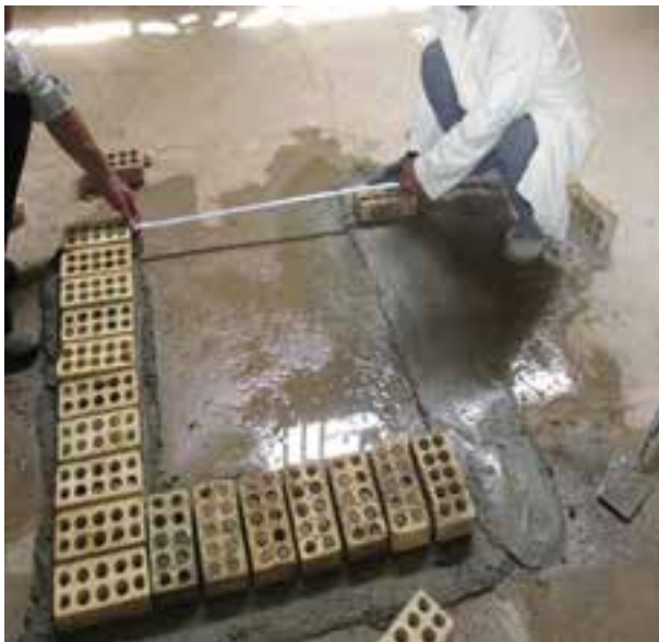
شکل ۱ - ۳۳ (ب): جدا کردن اندازه دو طرف دیگر
