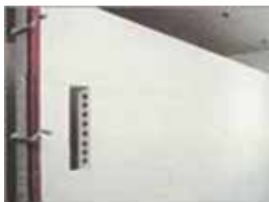
شکل ۱ - ۳۷: دیوار جداکننده با قطعات پیش ساخته گچی
