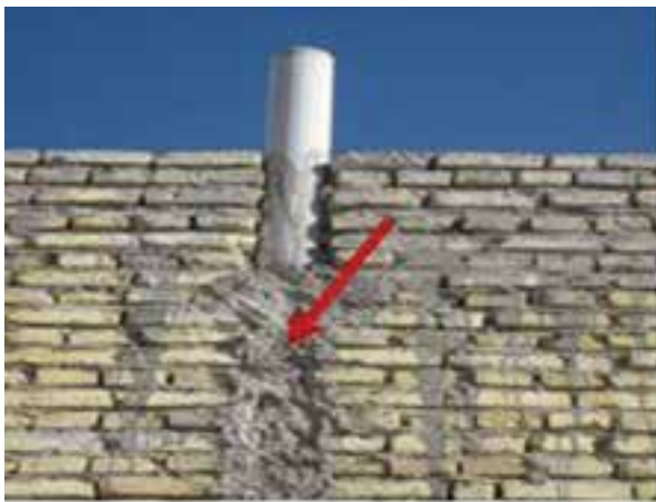
شکل ۱ - ۶۵: پر کردن درز لوله‌ها
