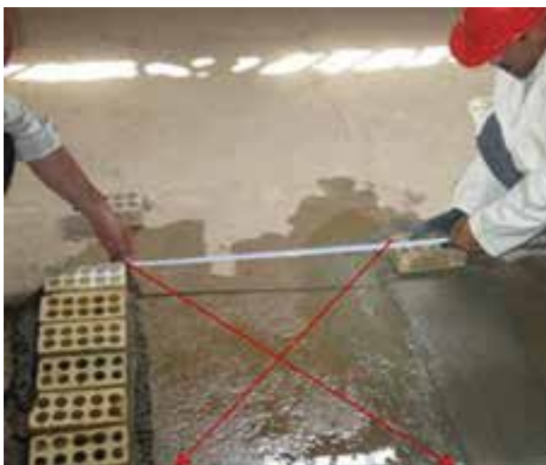
شکل ۱ - ۳۳ (ب): جدا کردن اندازه دو طرف دیگر
