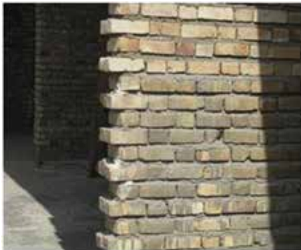
شکل ۱-۵۲: لابند در دیوار آجری
