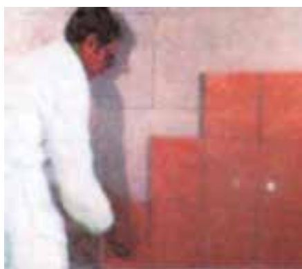
شکل ۱ - ۴۳: نصب کاشی روی قطعات پیش ساخته گچی
