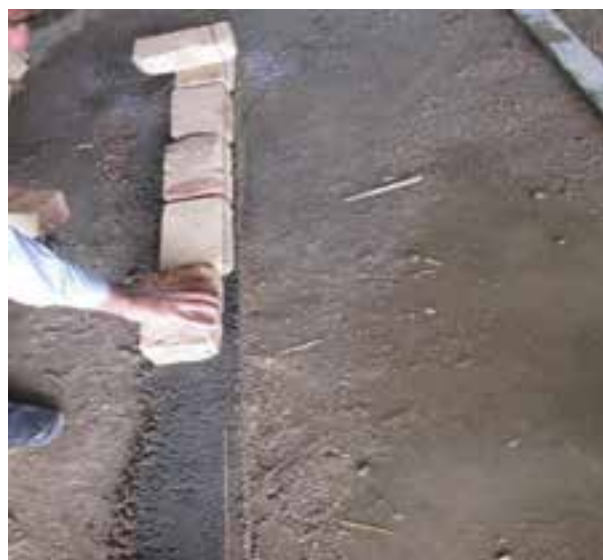
شکل ۱-۷۴: نحوه چیدن آجر در امتداد ریسمان کار
