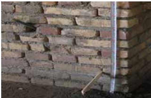
شکل ۳-۳۳: جدا کردن خط تراز روی دیوار
