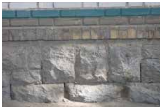
شکل ۱-۱۵ : کاربرد سنگ در پایه های ساختمان
