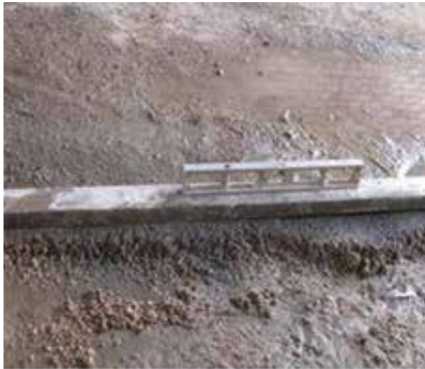
شکل ۱- ۶۹: تراز کردن روی ملات
