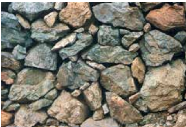
شکل ۸-۲- نمای دیوار لاشه چینی شده بدون ملات
