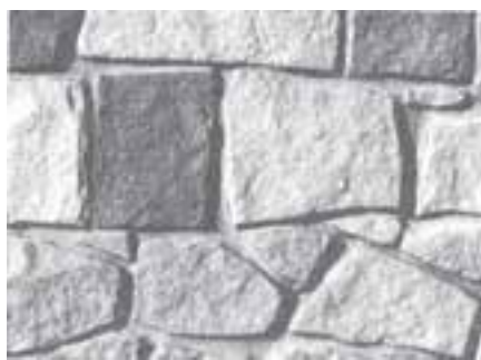
شکل ۱۱-۲- دیوار با سنگ چندوجهی سرتراش رجدار
