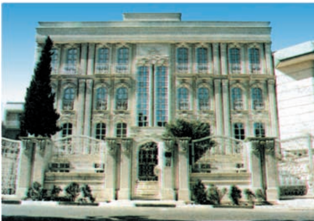
شکل ۲۱-۵- اجرای سیمان‌بری باروک
