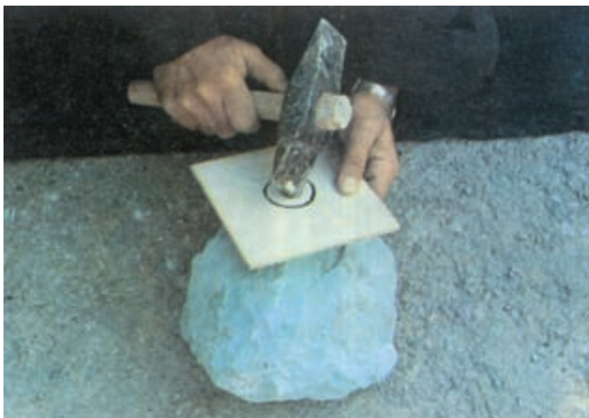
شکل ۷-۶- نحوه ی سوراخ کردن کاشی از ناحیه ی پشت کاشی به وسیله ی تیشه ی دوسر
