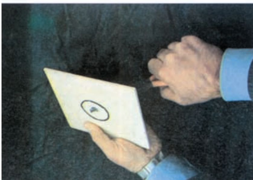
شکل ۸-۶- نحوه ی سوراخ کردن کاشی به وسیله ی انبردست از ناحیه ی پشت کاشی
