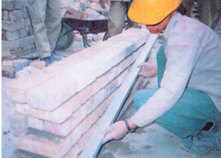
— مرحله‌ی اول طریقه‌ی ضربدري کنترل‌نما با شمشه (کنترل پیچیدگی نما)
