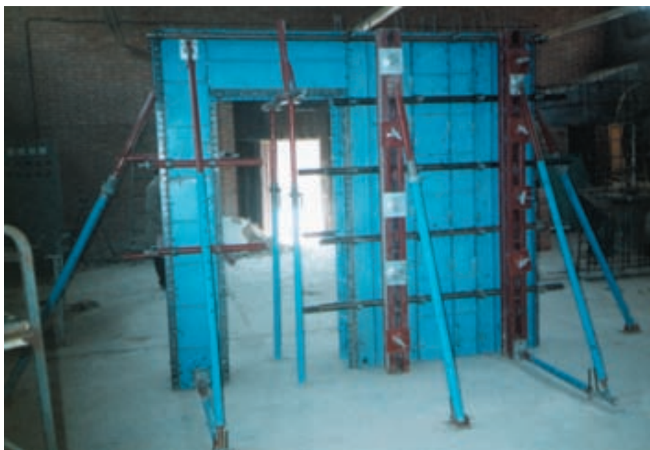
شکل ۲۹-۸ - قالب تکمیل شده ی دیوار و ستون بتنی
