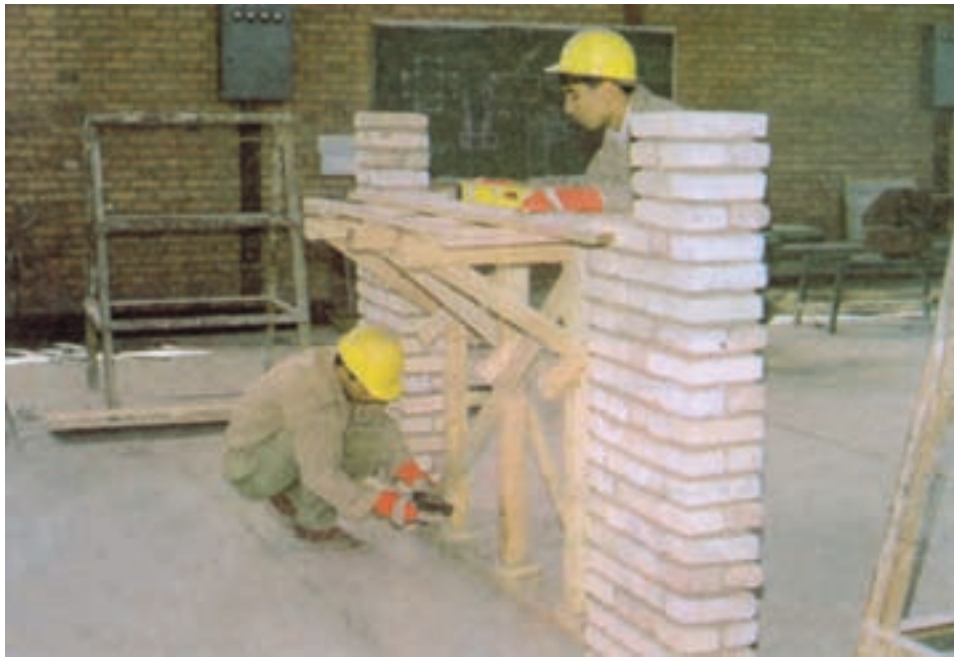
شکل ۳-۶- صفحه‌ی کف قالب نصب شده بر روی شمع‌ها
