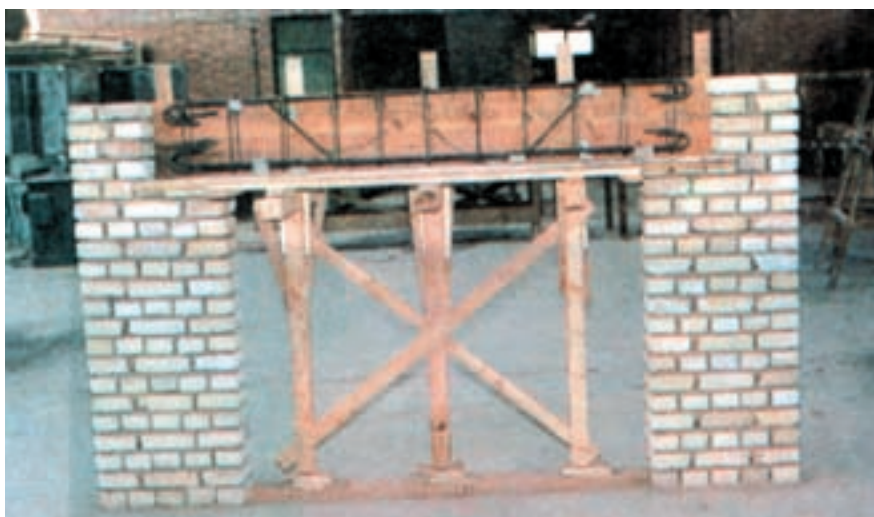
شکل ۱۳-۳- نمایش مجموعه‌ی میل‌گرد و فاصله‌نگه‌دارهای مربوط در قالب پوتر
