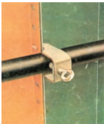
شکل ۹-۷- اتصال پشت‌بند لوله‌ای توسط گیره‌ی متوسط به بدنه‌ی قالب
