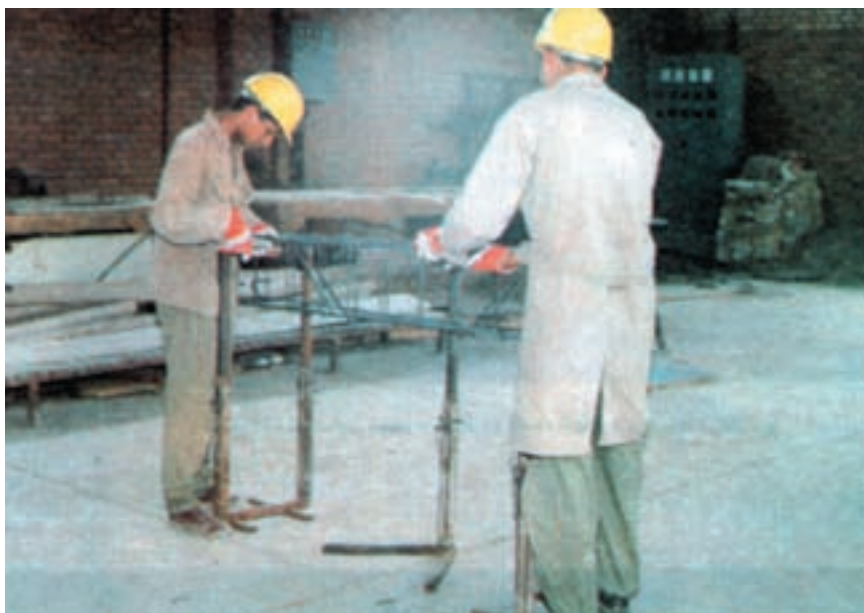
شکل ۱۲-۳- طریقه‌ی مونتاژ آرماتورهای یک پوتر کوچک
