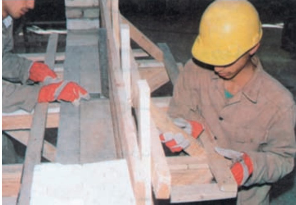
شکل ۱۱-۳- نصب گوننه، گونیاکردن و نصب دستک‌ها
