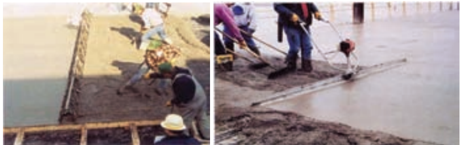
شكل ۶-۲۵- استفاده از شمشه‌هاى داراى ويبره براى تراز كردن و متراكم نمودن سطح، به صورت همزمان
