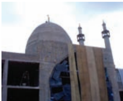
مسجد جامع شهر بيم که پس از زلزله کاملاً سالم مانده است. اسکلت اين بنا بتنی است.
