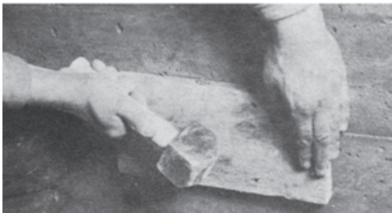
متراکم کردن با یک تخته و چکش
