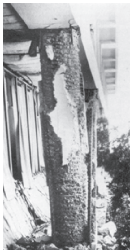
در این شکل یک ستون با مقطع دایره‌ای و خاموت دور پیچ نشان داده شده که در اثر طراحی نامناسب سازه در مقابل نیروی جانبی طبقه‌ی اول بسیار نرم بوده و سازه دچار تغییر شکلی در حدود ۶۵ سانتی‌متر شده و به ستون‌ها آسیب اساسی وارد ساخته است.
