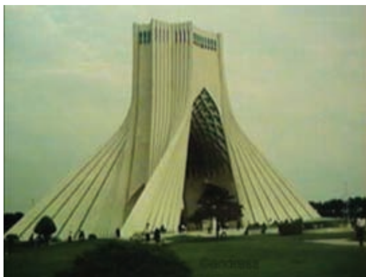
شکل ۱-۵- برج میدان آزادی تهران در حال ساخت و پس از ساخت
