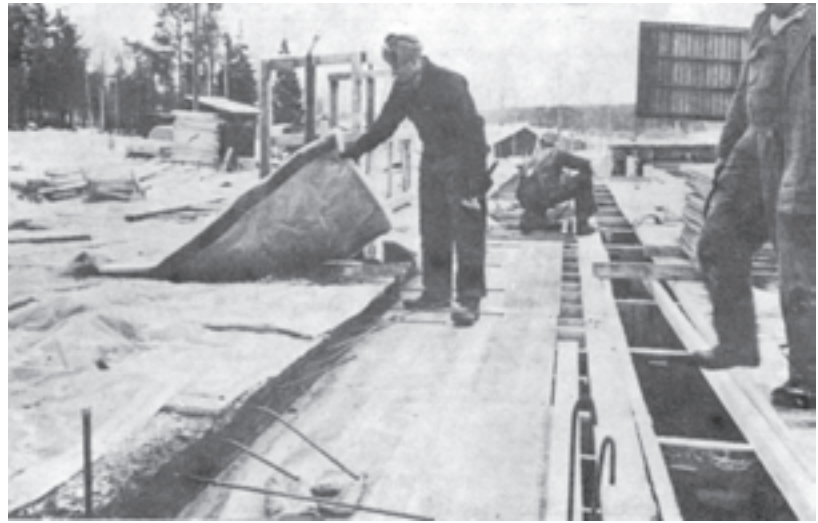
شکل ۳۰-۶- روکش‌های عایق ساخته شده با الیاف معدنی در ورقه‌های پلاستیک برای محافظت دال
