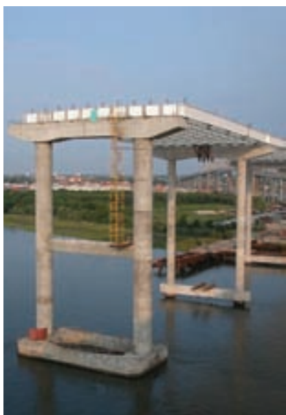
پایه‌های بتنی یک پل
