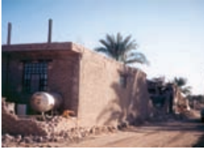
ساختمان نیمه اسکلت با شنازهای افقی و قائم که دچار کمترین آسیب شده است.
