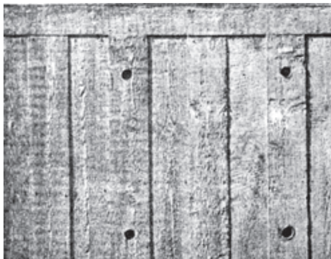
شکل ۶-۳۴- نمونه‌ای از محل‌های مهاره‌ی پر نشده
