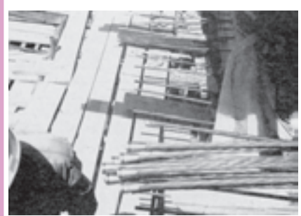
گوه گذاری کابل ها برای پیش تنیدگی بتن
