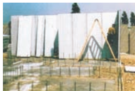
نصب صفحات بر روی فونداسیون اجرا شده
