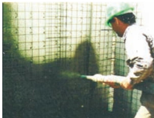
بتن پاشی روی دیوار
