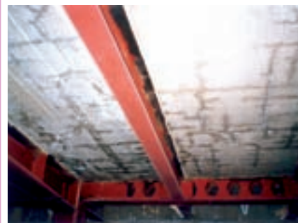
دال مرکب بتنی پس از بتن‌ریزی
