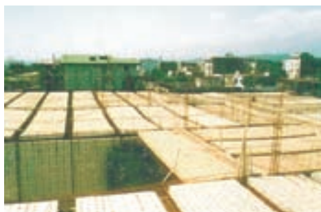
نصب صفحات سقف
