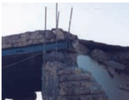
عبور آهن نعل درگاه از شناژ و عدم بتن ریزی در آن نقطه که باعث خرابی گردیده است.
