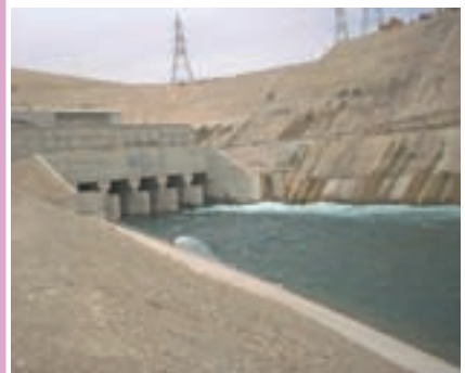
کانال بتنی آب
