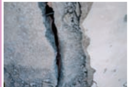
ایجاد ترک در سقف تیرچه بلوک به دلیل کیفیت نامطلوب بتن و عدم قرار دادن کلاف در سقف تیرچه بلوک می باشد. وجود کلاف عرضی در سقف می تواند صلبیت و یکپارچگی سقف را حفظ کند.
