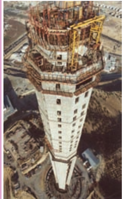
برج مخابراتی میلاد در حال ساخت
