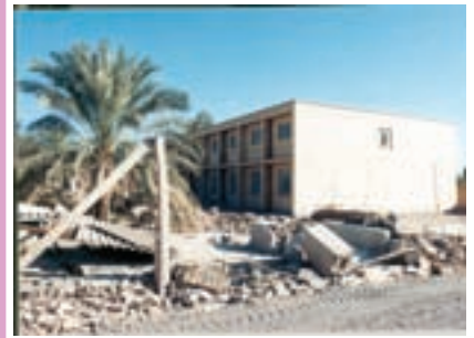
تخریب تیر برق که می تواند علاوه بر قطع برق پس از زلزله، موجب خسارت هایی از قبیل آتش سوزی و ... شود.
