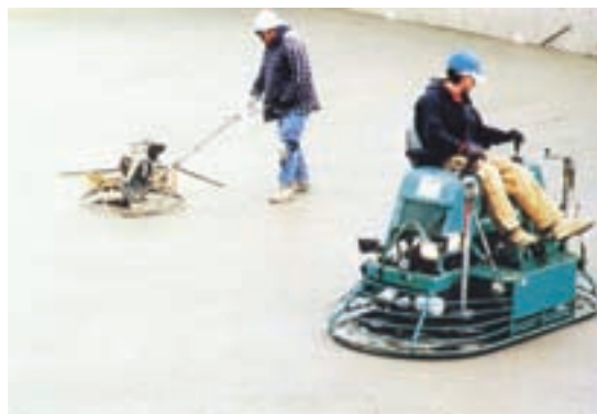
شکل ۶-۲۹- پرداخت نهایی با ابزار مکانیکی
