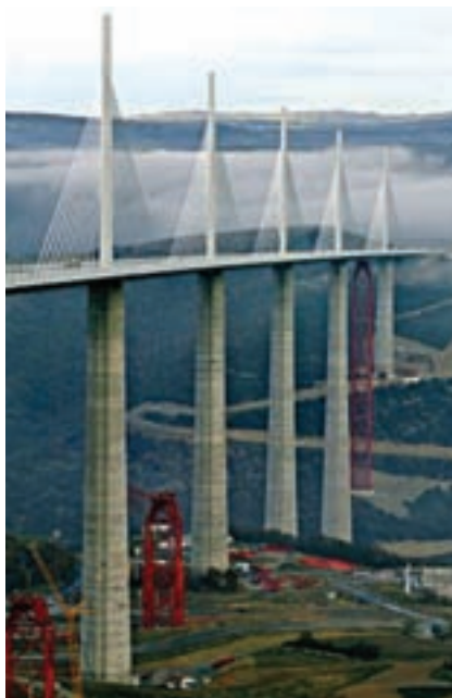
پل کابلی با پایه‌های بتنی
