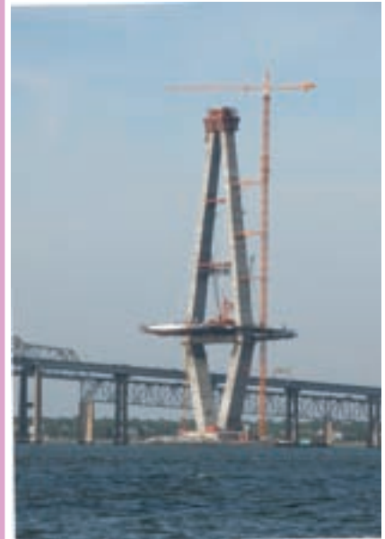
پایه‌ی بتنی یک پل کابلی
