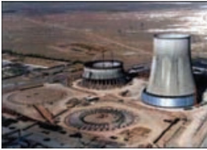
برج‌های خنک‌کننده‌ی نیروگاه برق اصفهان در حین ساخت
