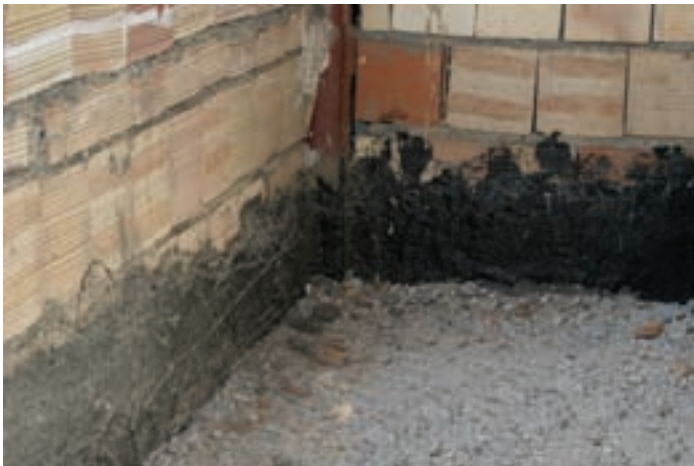
تصویر ۱۶ - عایق کاری کف سرویس بهداشتی
