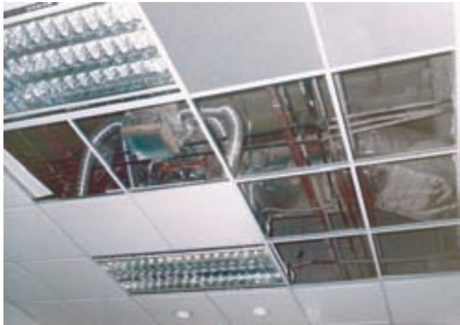
تصویر ۲۰ - زیر سازی سقف کاذب
