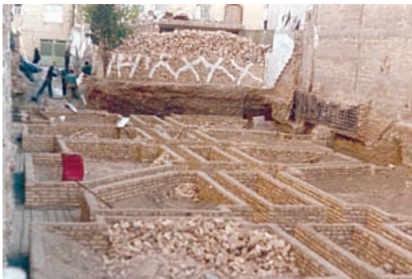
تصویر ۵ - قالب بندی آجری بی ساختمان
