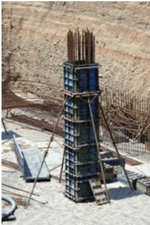
تصویر ۴ - قالب‌بندی فلزی ستون
