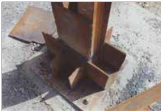
شکل ۱۶۸-۲ اتصال گیردار
