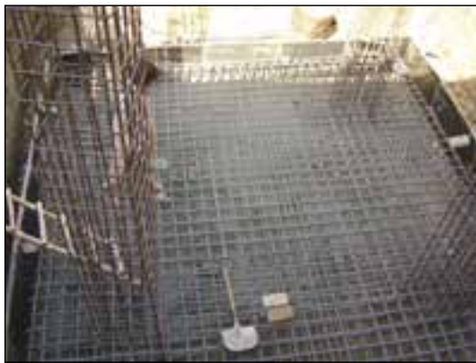
شکل ۱۵۱-۲ آرماتورگذاری پی صفحه‌ای با ستون‌های بتنی
