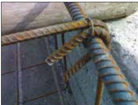
شکل ۲-۱۴۲ قلاب سرخاموت و بستن آن با مفتول
