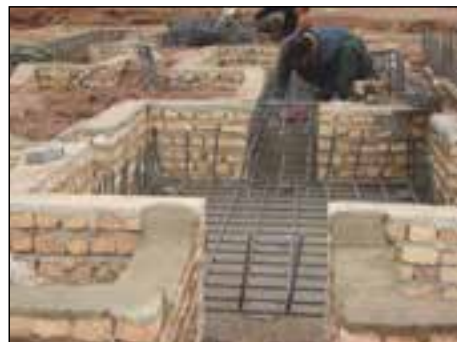
شکل ۱-۸۲ قالب‌بندی آجری در اطراف پی
