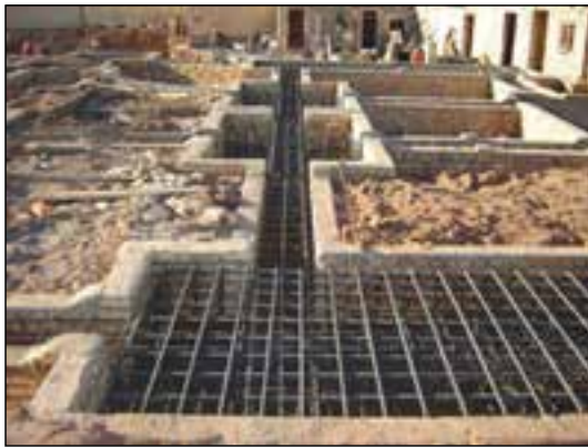
شکل ۷۰-۲ میلگردگذاری در پی کلاف بندی
