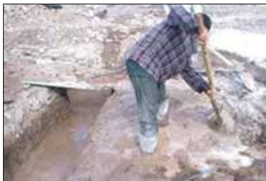
شکل ۱-۳۱ اجرای شفته آهک در فونداسیون
