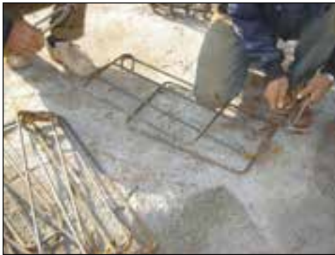
شکل ۲-۱۴۰ خم آرماتور و ساخت خاموت
