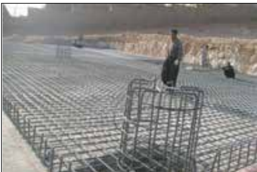
شکل ۱۵۲-۲ آرماتورگذاری پی صفحه‌ای با ستون‌های بتنی
