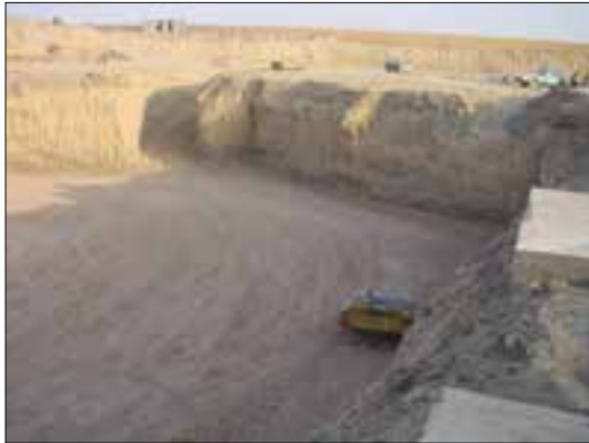
شکل ۸۴-۱ زمین گودبرداری شده
