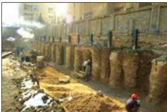
شکل ۸۸-۱ مهاربندی با پشت بند خاکی ستونی
