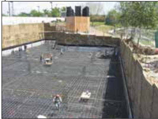
شکل ۱-۶۲ پی بتن مسلح یکپارچه (رادیه ژنرال)
