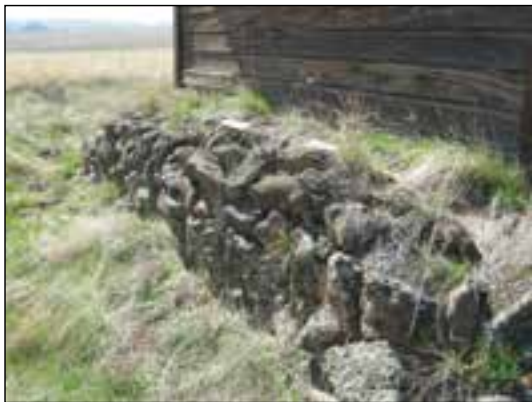
شکل ۱-۳۲ پی سنگی با سنگ لاشه
