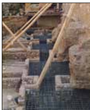
شکل ۹۰-۱ مهاربندی با شمع چوبی
