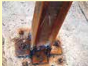
اتصال نامناسب و ضعیف ستون به بیس پلیت
