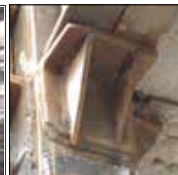
اتصال تیر به ستون به صورت لچکی
