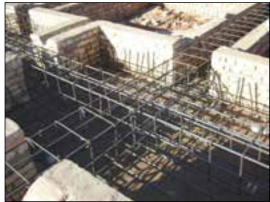
شکل ۷۱-۲ عبور میلگردهای شناژ در پی
