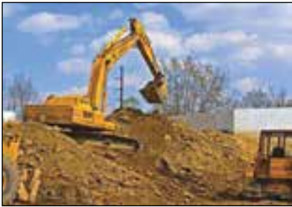
شکل ۱-۱۳- کندن زمین با وسایل مکانیکی
