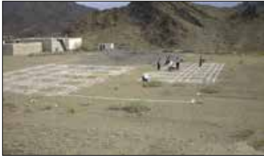
شکل ۸۳-۱ پیاده کردن نقشه روی زمین
