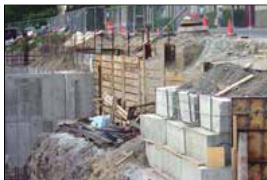
شکل ۹۱-۱ مهاربندی با دیوار مانع چوبی
