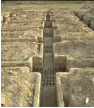
شکل ۴۸-۱ آرماتورگذاری پی تکی کلاف بندی شده
