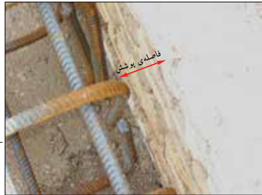
شکل ۱۲۶-۲ فاصله‌ی پوشش و قلاب سر میل‌گردها
