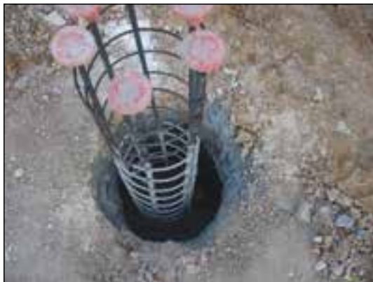
شکل ۱-۷۳ پی چاهی در حال اجرا
