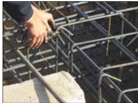
شکل ۲-۱۴۱ بستن خاموت دور آرماتور اصلی شناژ
