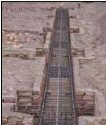
شکل ۷۲-۲ پی و شناژ قبل از بتن ریزی
