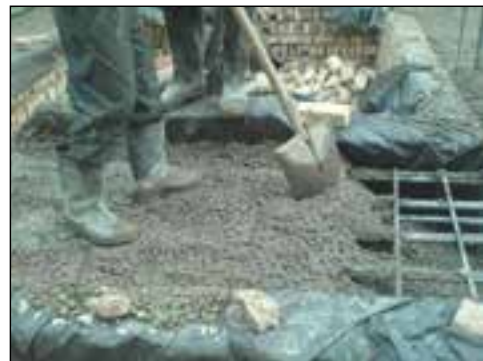
شکل ۲-۱۴۵ مرحله ی بتن ریزی داخل پی
