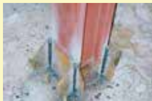
اتصال مناسب و جوش صحیح
