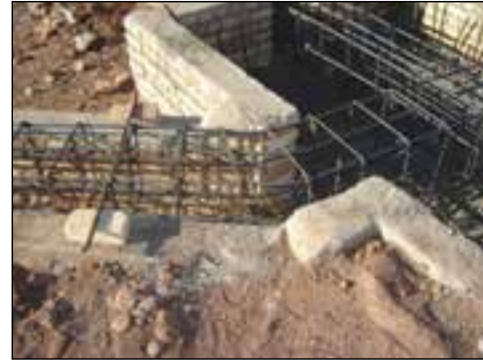
شکل ۲-۱۴۳ آرماتورهای شناژ و پی
