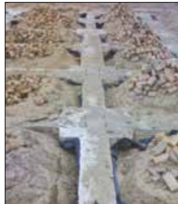
شکل ۷۳-۲ پی و شناژ بعد از بتن ریزی
