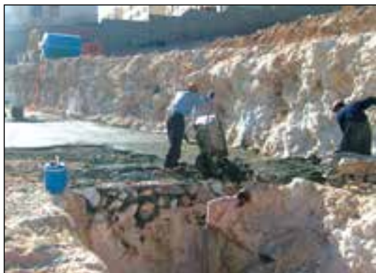
شکل ۸۷-۱ گودبرداری دستی (با بیل و کلنگ)
