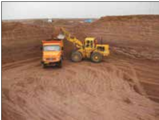
شکل ۸۵-۱ گودبرداری با لودر در زمین نامحدود
