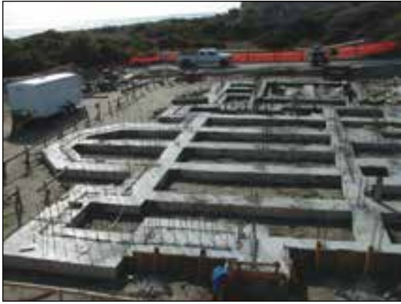
شکل ۱-۵۶ پی بتن مسلح نواری شبکه ای زیرستون
