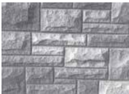
شکل ۱۰-۲- دیواره‌ی سنگ بادبر سرتراش گونیا شده به رج برده شده
