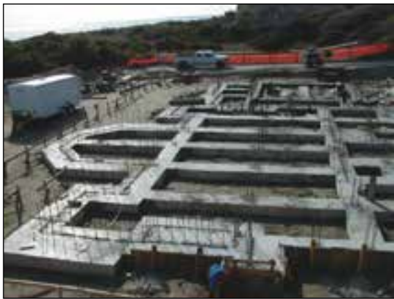
شکل ۳-۶۲ پی بتن مسلح نواری شبکه ای زیرستون
