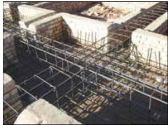
شکل ۳-۱۳۵ عبور میلگردهای شناژ در پی
