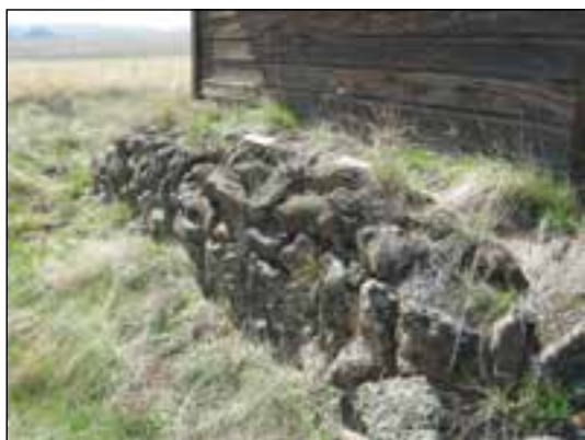
شکل ۳-۴۰ پی سنگی با سنگ لاشه
