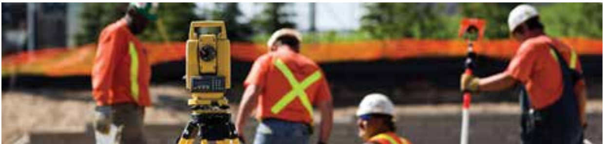
شکل ۴-۱. پیاده کردن با دوربین نقشه‌برداری
