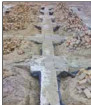
شکل ۳-۱۳۷ پی و شناژ بعد از بتن‌ریزی
