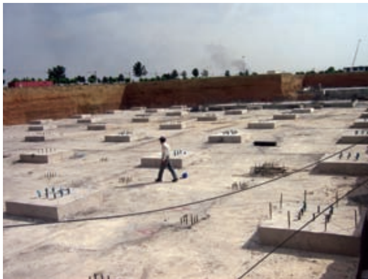
شکل ۷-۳- شالوده‌ی گسترده و کتیبه‌های روی آن
