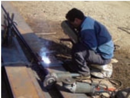
ب- جوشکاری روی درز
