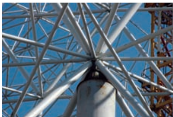
شکل ۱۰-۲۰- نحوه‌ی اتصال اعضای فرپای فضاکار
