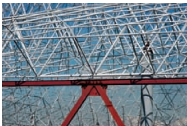
شکل ۱۰-۲۰- نحوه‌ی اتصال اعضای فرپای فضاکار
