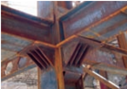
شکل ۴-۱۷- ستون دابل با ورق تقویتی
