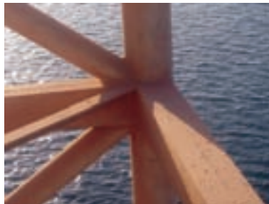
ستون با مقطع دایره در یک سازه صنعتی در جزیره خارگ
