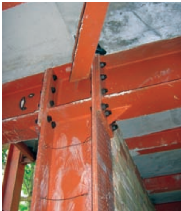
شکل ۷-۸- اتصال پیچی در سافتمان اسکلت فولادی
