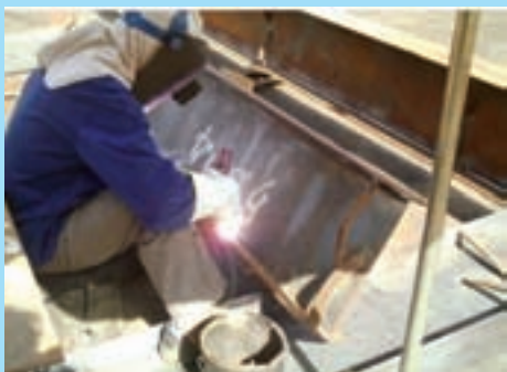
جوش طولی به روش دستی
