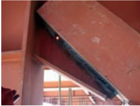
نمونه‌ای از اتصال جوشی در مهاربند سافتمان
