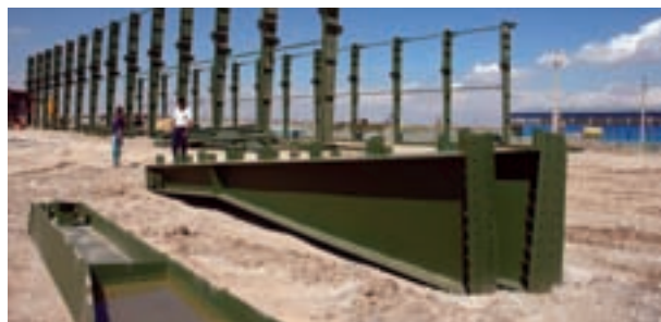
شکل ۵-۱۵- شاهتیرهای ساخته شده از تیر ورق
