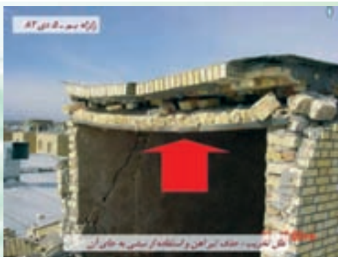
علل تخریب: حذف تیر آهن و استفاده از نبشی به جای آن
