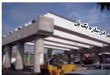
نمونه‌ای از تیر در سازه یک پل فولادی
