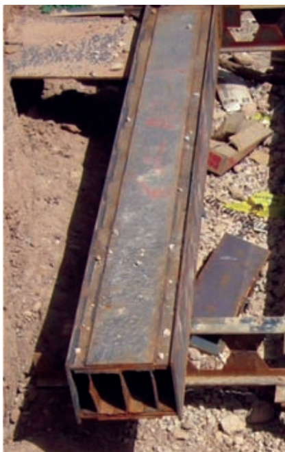
شکل ۴-۱۸- مقطع مرکب سه‌تایی با ورق تقویتی
