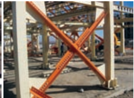
الف- مهاربندهای همگرا در اسکلت فولادی
