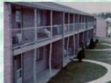
نمونه هایی از کمانش کلی ستون
