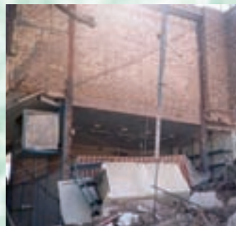
استفاده از میلگرد به جای مهاربند برای تحمل نیروهای جانبی ناشی از زمین لرزه
