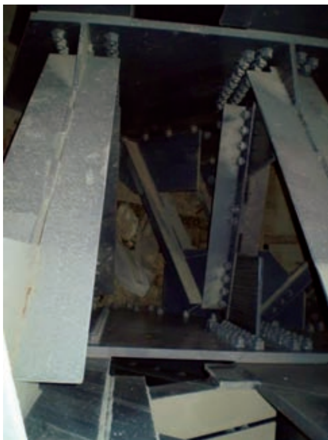
شکل ۱۰-۶ - اتصال پیچ و مهره‌ای اعضای خرپاها
