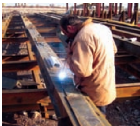
شکل ۴-۱۵- جوشکاری ستون جفت (وی شاسی کار)
