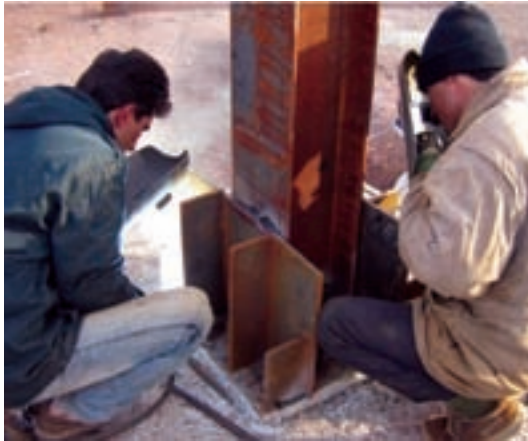
شکل ۴-۲۶- جوشکاری کامل پای ستون و مملقات آن
