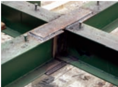
نمونه‌ای از اتصال جوشی در مهاربند سافتمان
