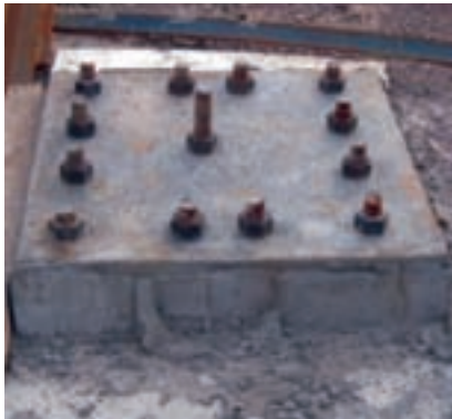
(ب) پس از بتن‌ریزی
