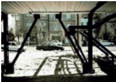
ب- مهاربند ذوزنقه واگرا در اسکلت فولادی
