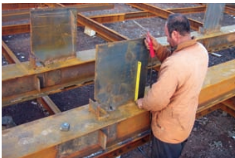
شکل ۴-۲۲- نصب ملامقات ستون روی شاسی‌های مونتاژ
