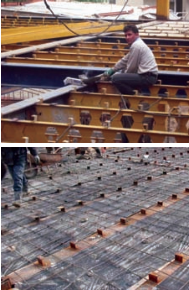
شکل ۵-۲۵- مراحل اجرای سقف کامپوزیت
