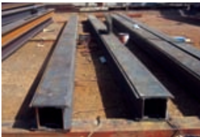
شکل ۴-۱۶- ستون دابل با ورق تقویتی یکسره
