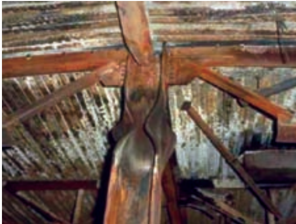
شکل ۴-۵- کمانش موضعی ستون
