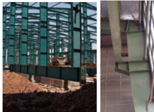
فلنج انتظار در ساختمان صنعتی
