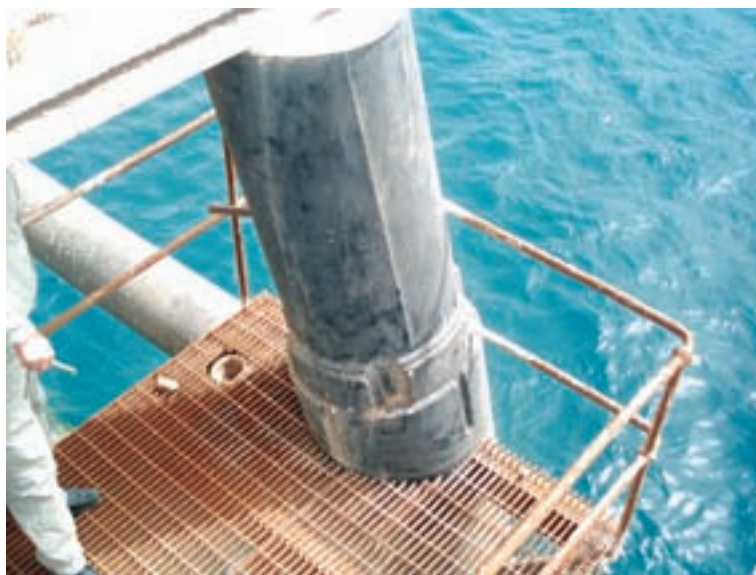
استفاده از پوشش قیری در سازه دریایی
