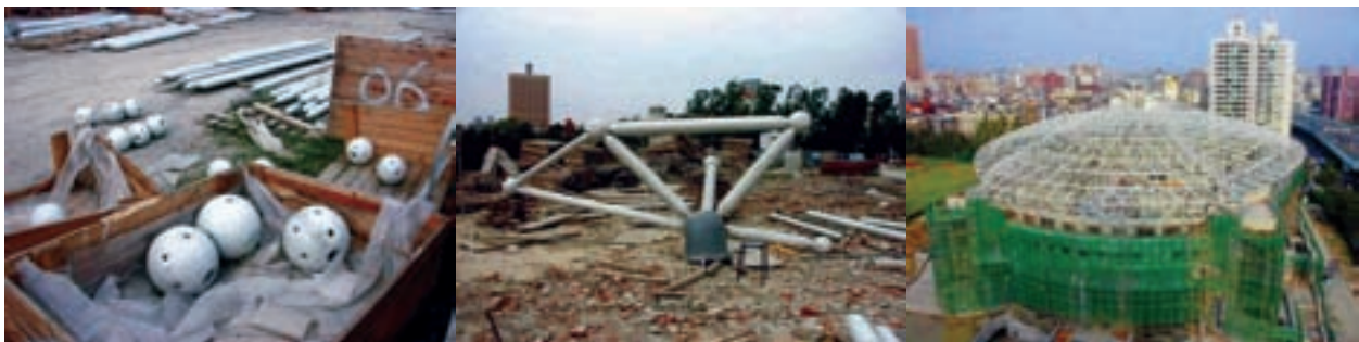
شکل ۱۰-۱۵- نمایی از یک فرپای فضایی
