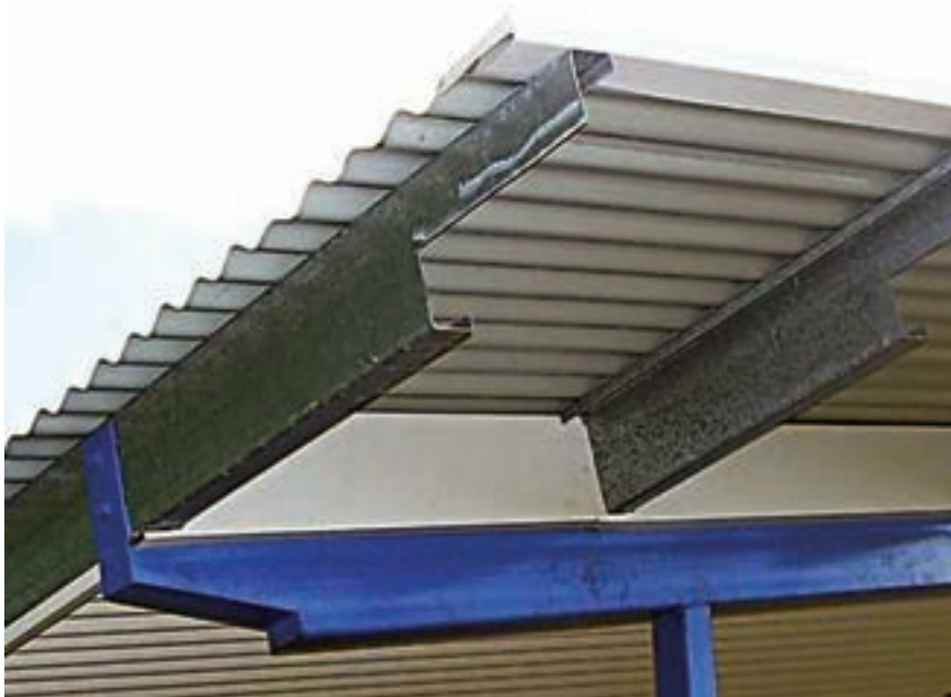
شکل ۵-۱۹- لایه جهت نصب پوشش در ساختمان صنعتی
