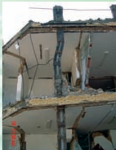
نمونه هایی از کمانش کلی ستون
