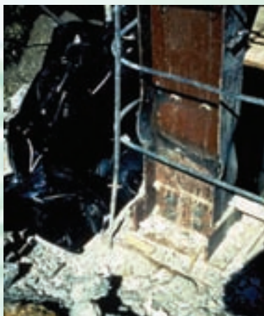
کمانش موضعی بال ها و جان ستون در پایین ستون طبقه ی اول در گوشه ی ساختمان
