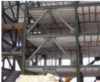
شکل ۹-۴- انواع مهاربند قائم در سافتمان
