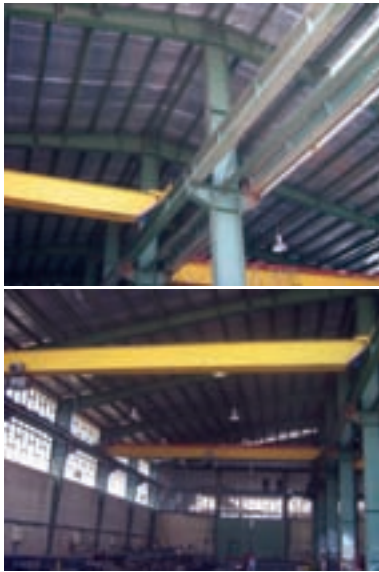
پ- کاربرد جرثقیل سقفی در ساختمان صنعتی
