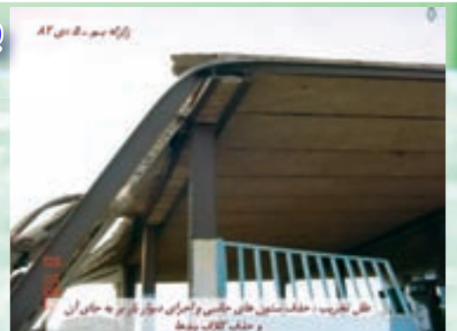
علل تخریب: حذف ستون‌های جانبی و اجرای دیوار باربر به جای آن و حذف کلاف بندها
