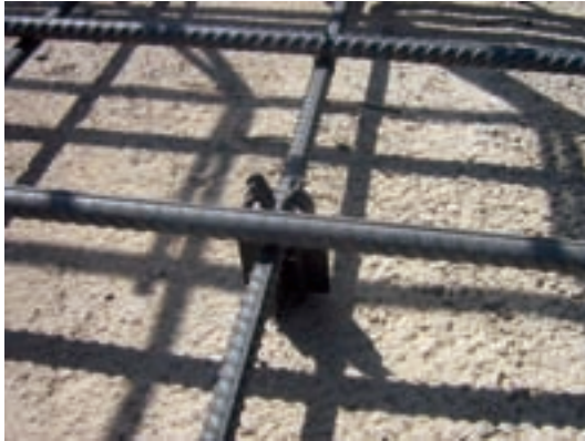
شکل ۳-۱۱- استفاده از فاصله انداز (Spacer) جهت فاصله دادن آرماتورهای کف با بتن مگر
