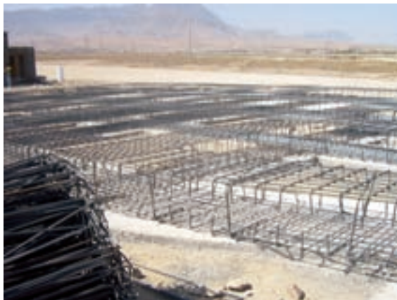
ب - آرماتوربندی شالوده قبل از قالب بندی
