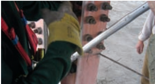
شکل ۷-۳- استفاده از پیچ‌های پرمقاومت در اتصالات
