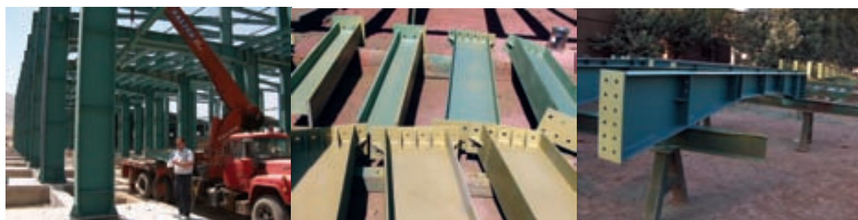
سافت و نصب اسکلت صنعتی
