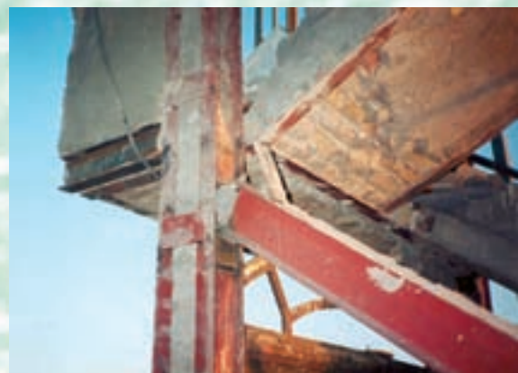
ضعف اتصال مفصلی تیر و ستون موجب تخریب سازه در زلزله شده است.
