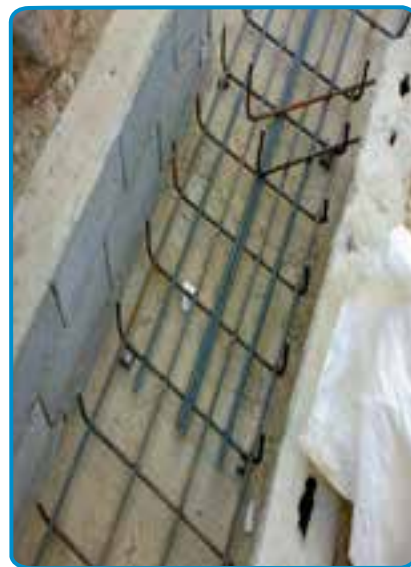
شکل ۱۱-۷- قرار دادن میلگردهای تقویتی
