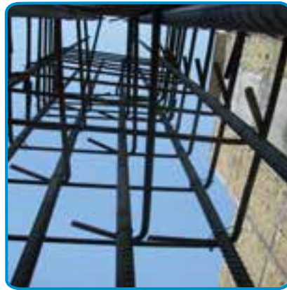
شکل ۱۹-۷- کار گذاشتن میلگردهای انتظار ستون، در فونداسیون
