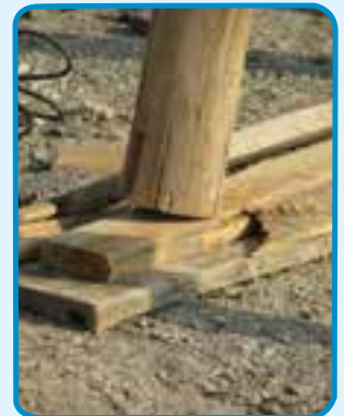
شکل ۲۵-۳- استفاده از گوه جهت تنظیم ارتفاع
