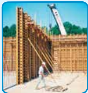
شکل ۱۹-۳- اجرای دیوار بتنی فایبر گلاس برای
