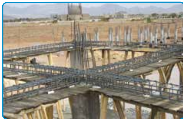
شکل ۷-۲۷- رعایت فاصله پوشش بتنی در کف
