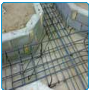
شکل ۱۳-۷- قرار دادن میلگردهای تقویتی پخها
