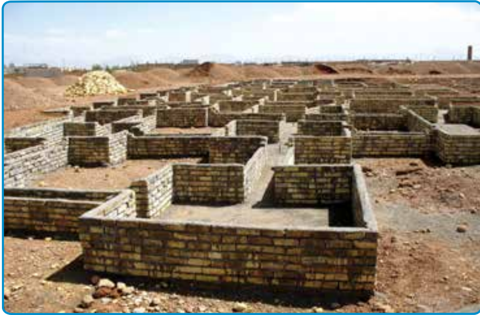
شکل ۱۵-۳- استفاده از قالب آجری برای اجرای پی
