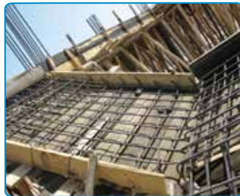
شکل ۳۸-۷- اجرای میلگردهای دال پله
