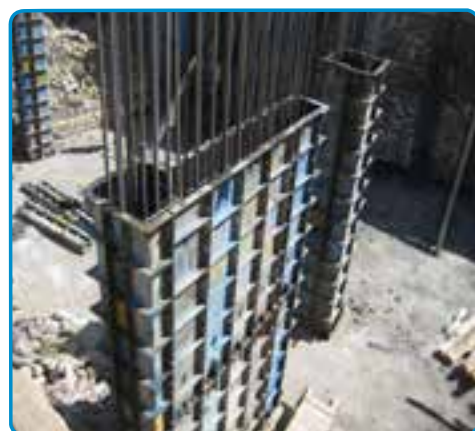
شکل ۳-۳۵- قالب فلزی برای اجرای دیوار بتنی
