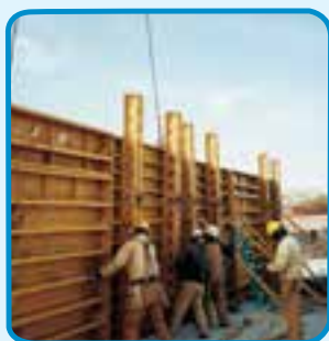
شکل ۳-۳۶- قالب فایبر گلاس برای اجرای دیوار بتنی
