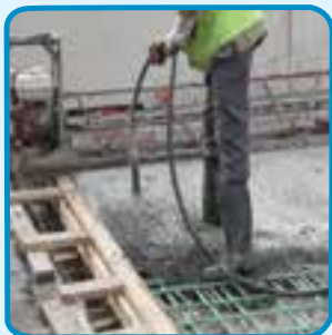
شکل ۱۴-۳- ویبراتور یا لرزاننده بتن داخل قالب
