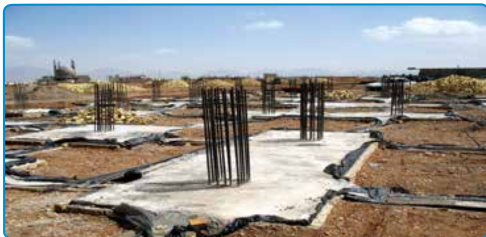
شکل ۱۰-۳- استفاده از پلاستیک در پی
