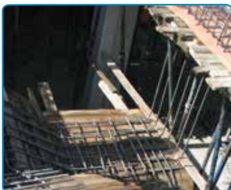
شکل ۴۱-۷- اجرای میلگردهای دال پله
