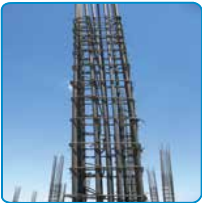
شکل ۱۹-۷- کار گذاشتن میلگردهای انتظار ستون، در فونداسیون
