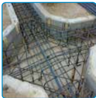
شکل ۱۴-۷- تکمیل میلگردگذاری محل اتصال ستون
