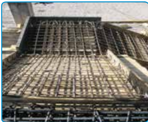
شکل ۳۷-۷- اجرای میلگردهای دال پله
