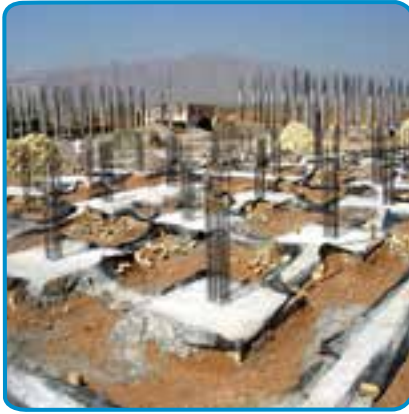
شکل ۱۷-۷- اجرای خاموت و سنجاقک
