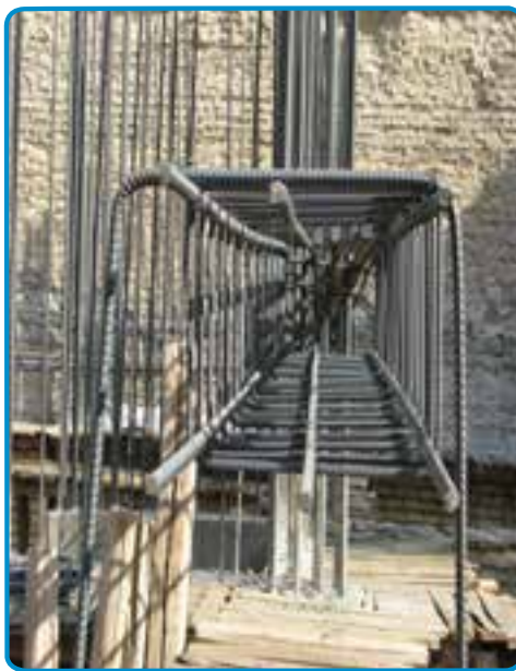
شکل ۳-۴۵- میلگرد طولی در تیر
