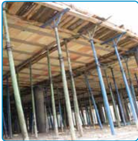
شکل ۲۱-۳- استفاده از شمع‌های فلزی جهت نگهداری قالب‌ها
