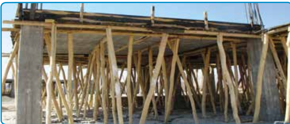
شکل ۲۴-۳- استفاده از شمع‌های چوبی جهت نگهداری قالب‌ها
