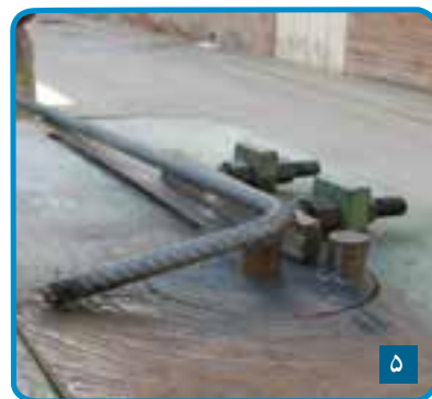
شکل ۳-۶۴ - خم کردن میلگرد
