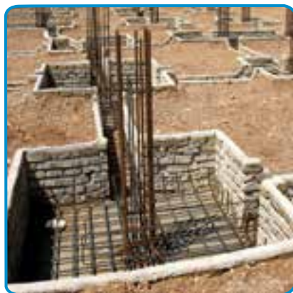
شکل ۴-۷- اجرای میلگردهای ریشه انتظار
