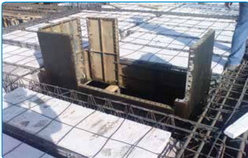
شکل ۳۵-۷- تکمیل قالب بندی
