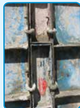
شکل ۱۳-۳- پشت بند قالب
