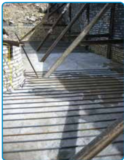
شکل ۳-۴۶- میلگرد طولی کف پی
