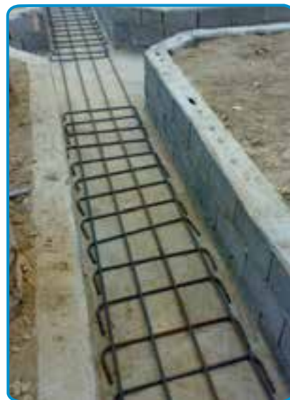
شکل ۸-۷- چیندن میلگردهای طولی و عرضی
