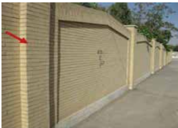
شکل ۱ - ۵۸ : وابند در دیوار حصارکشی
