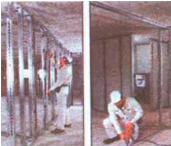
شکل ۱-۴۴ : قاب سازی جهت اتصال روکش های گچی
