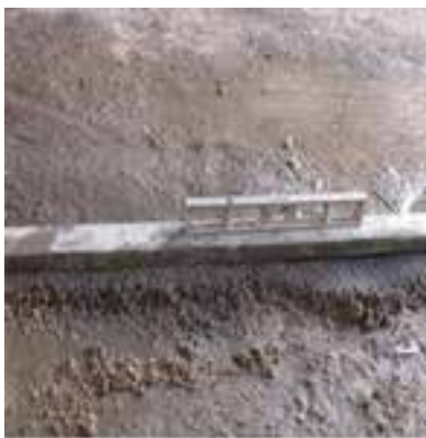
شکل ۱-۱۰۵: تراز کردن روی ملات
