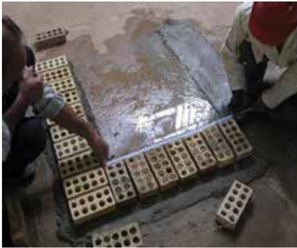
شکل ۱ - ۳۳ (الف): برداشتن طول دیوار
