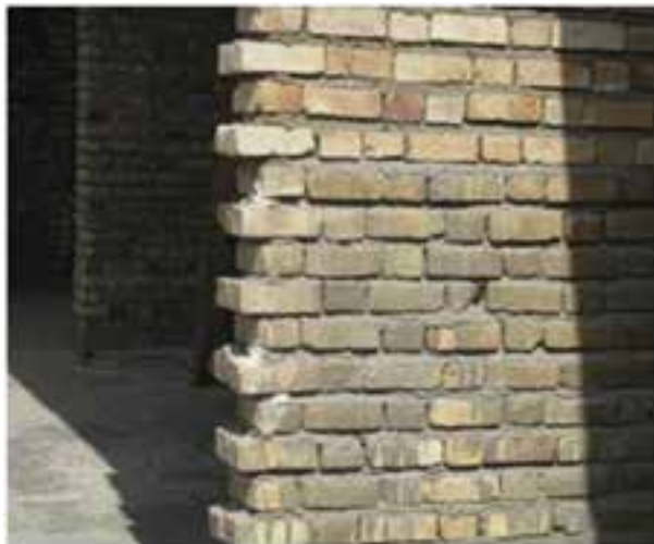
شکل ۱-۵۲: لابند در دیوار آجری
