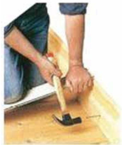
شکل ۳- ۲۹: نصب قرنیز چوبی با میخ
