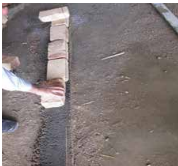
شکل ۱- ۷۴: نحوه چیدن آجر در امتداد ریسمان کار
