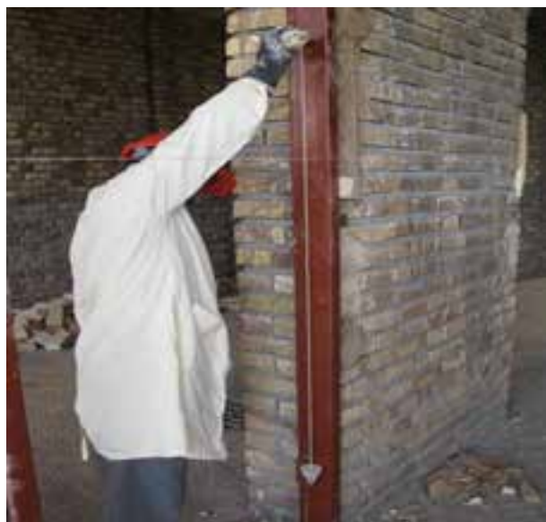
شکل ۳-۲۳: شاقول کردن وادار
