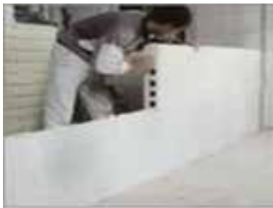
شکل ۱- ۳۹: جدا کردن فضا با قطعات پیش ساخته گچی
