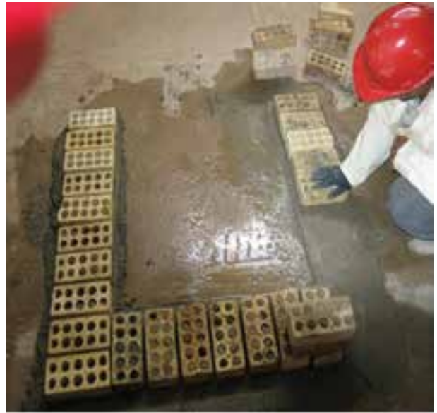
شکل ۱ - ۳۳ (ج): ریسمان کشی و چیدن ضلع سوم
