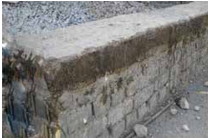
شکل ۱- ۲۹: کرسی چینی یا عایق کاری رطوبتی
