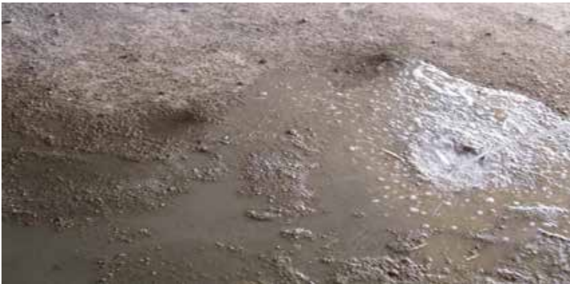
شکل ۱-۶۷: خیس کردن سطح زیر کار
