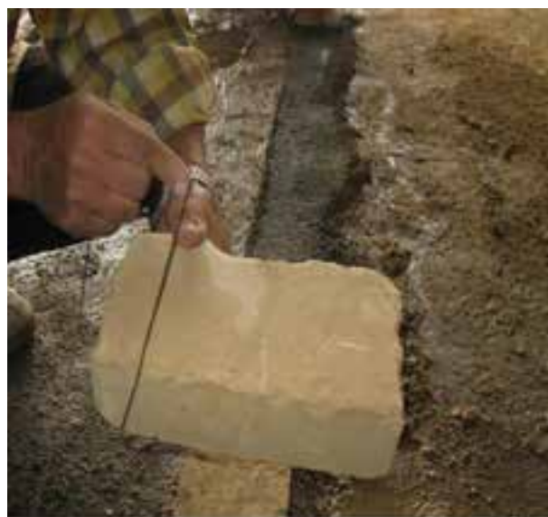
شکل ۱- ۸۹: نحوه بستن ریسمان کار به آجر
