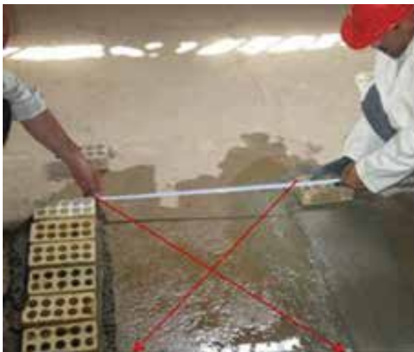
شکل ۱ - ۳۳ (ب): جدا کردن اندازه دو طرف دیگر
