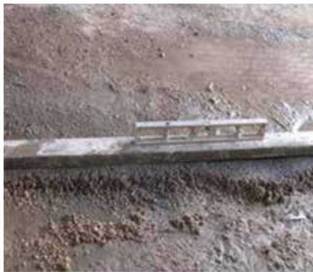
شکل ۱- ۶۹: تراز کردن روی ملات
