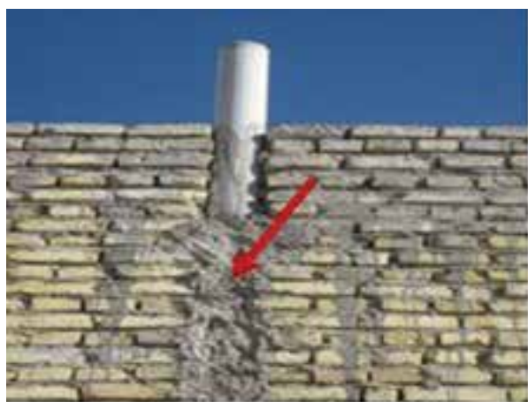
شکل ۱ - ۶۵: پر کردن درز لوله‌ها
