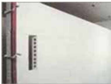
شکل ۱ - ۳۷: دیوار جداکننده با قطعات پیش ساخته گچی
