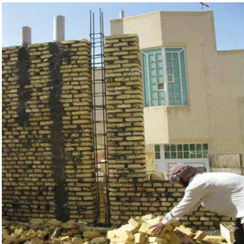
شکل ۱ - ۶۰: اتصال کلاف قائم و افقی در دیوار
