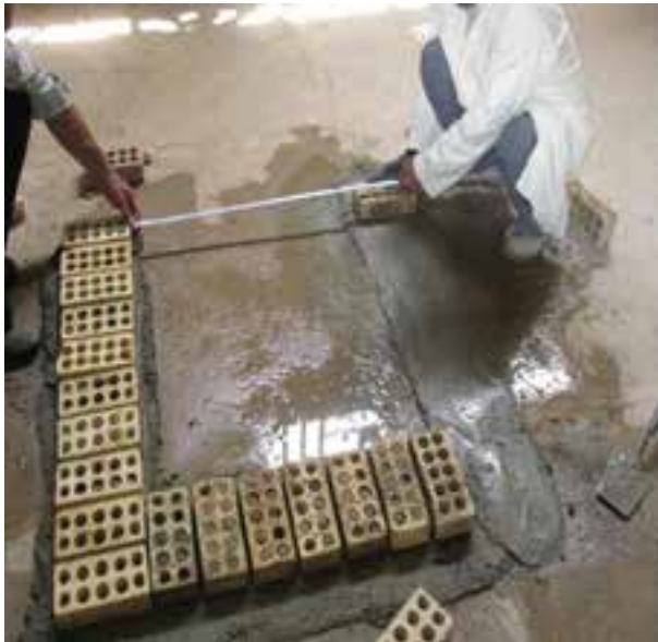
شکل ۱ - ۳۳ (ب): جدا کردن اندازه دو طرف دیگر
