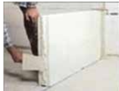
شکل ۱ - ۳۶: طریقه نصب بلوک های گچی
