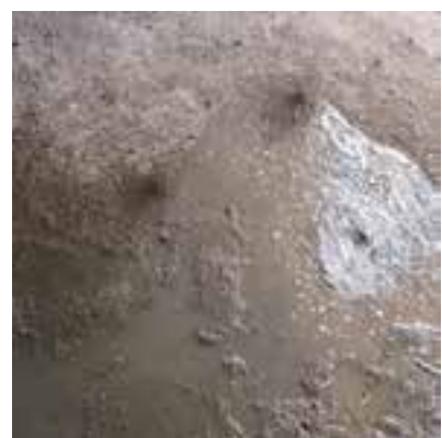
شکل ۱-۱۰۳: خیس کردن سطح زیر کار
