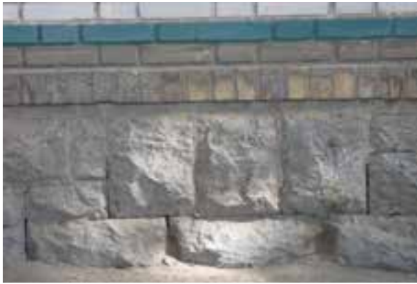
شکل ۱-۱۵ : کاربرد سنگ در پایه‌های ساختمان
