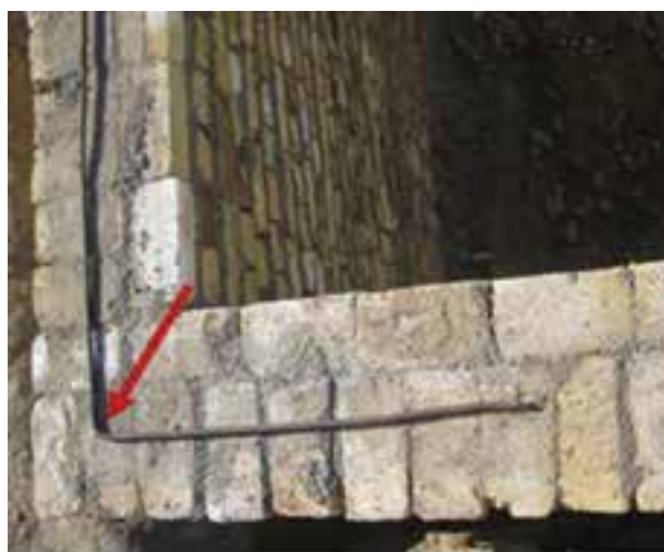
شکل ۱ - ۵۵: میلگرد گذاری در محل اتصال دو دیوار
