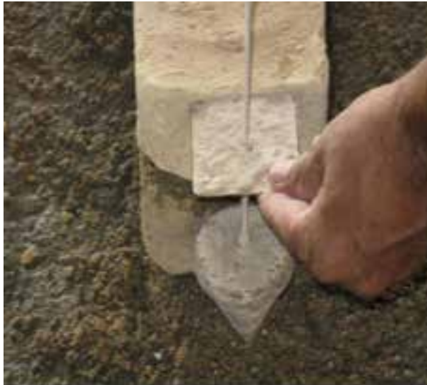
شکل ۱- ۷۷: شاقول کردن نبش کار
