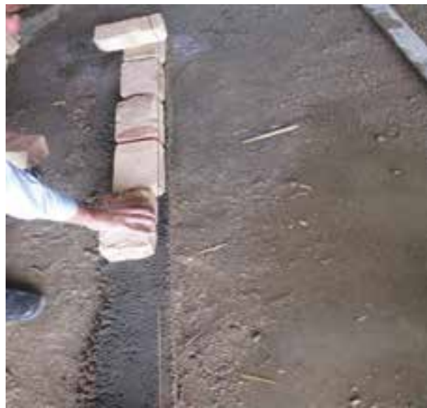
شکل ۱-۹۱: نحوه چیدن آجر در امتداد ریسمان کار
