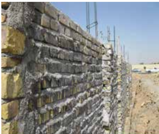
شکل ۱- ۲۶: دیوار آجری با کلاف بندی قائم
